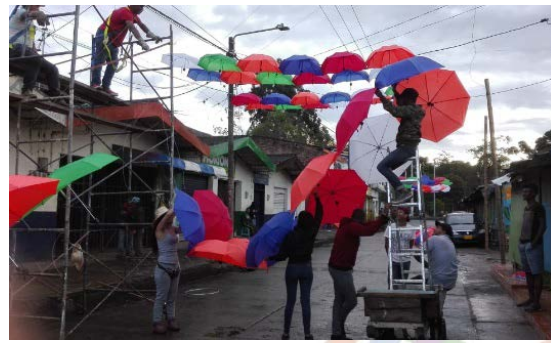
Foto 15: instalación de sombrillas
