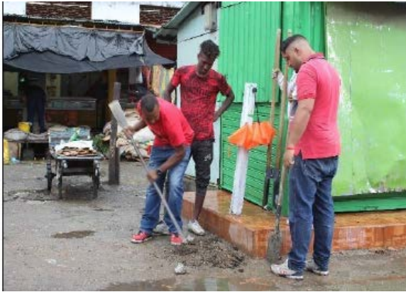
Foto 12: excavación para guaduas
