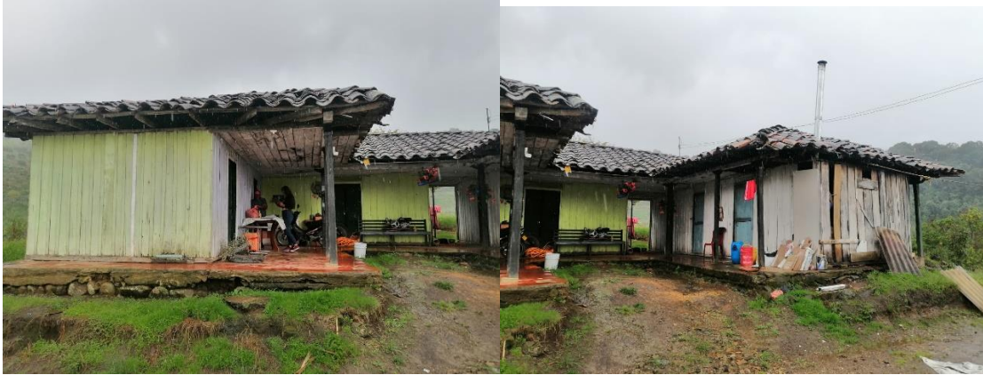
Figura 24. Fotografías de la vivienda N 6 (Fachada)
