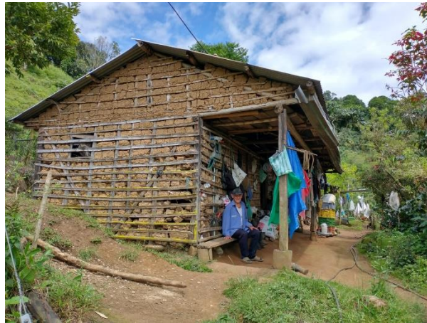
Figura 21. Fotografías de la vivienda N 5 (Fachada)
