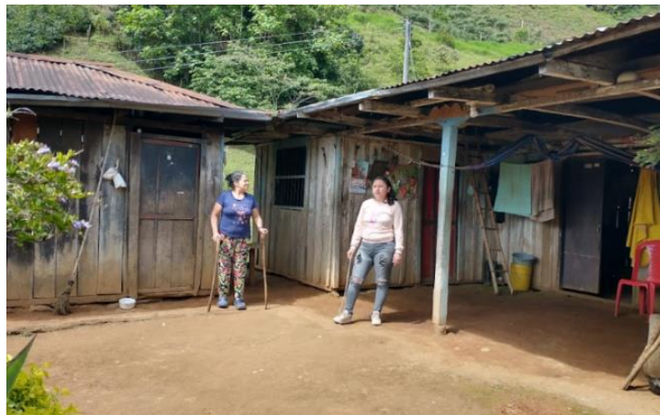
Figura 9. Fotografías de la vivienda N 2 (Fachada)
