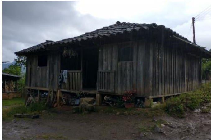
Figura 16. Fotografías de la vivienda N 4 (Fachada)
