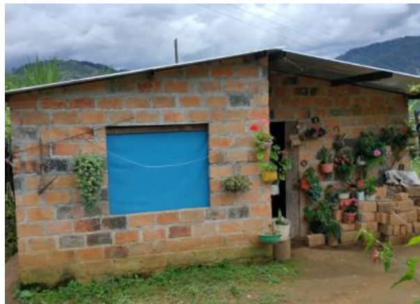
Figura 4. Fotografías de la vivienda N 1 (Fachada)
