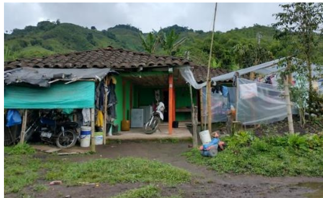
Figura 13. Fotografías de la vivienda N 3 (Fachada)
