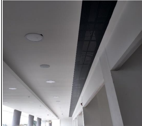
Instalación de carpintería metálica Fuente: Daniel Tejada
