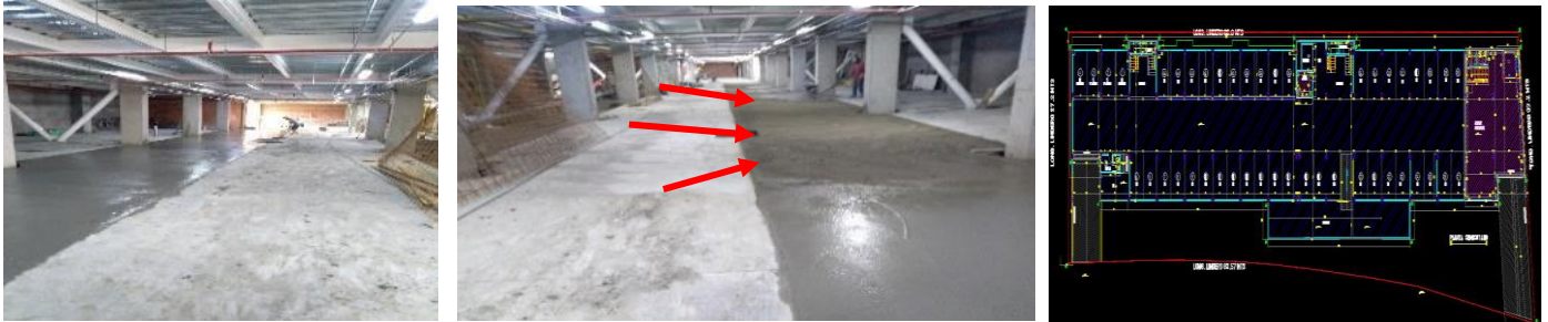
Ilustración 36: Fundición de losa de entrepiso del sótano Planta y Alzado.
