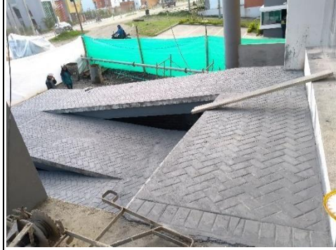
Tratamiento de adoquin Rampa Fuente: Daniel Tejada
