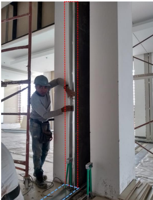
Ilustración 18: Detalle muro divisorio interno en Superboard 8 mm
