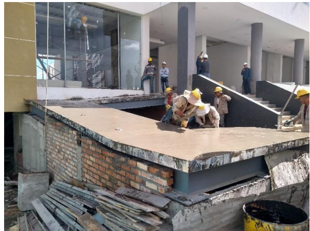
Ilustración 43: Ilustración 38: Fundición de rampas
