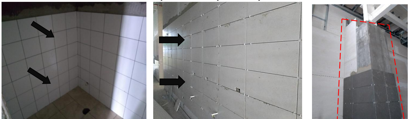
Ilustración 24: Enchape de baños en placa de superboard
