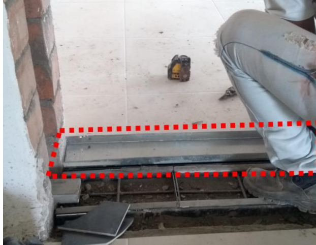
Ilustración 17: Detalle muro divisorio interno
