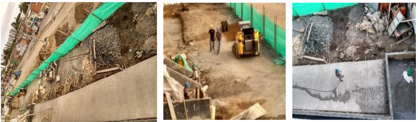
Ilustración 37: Fundición de losa de entrepiso en parqueaderos externos
