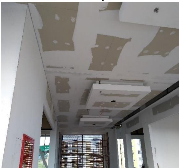
Tratamiento de junta no visible
