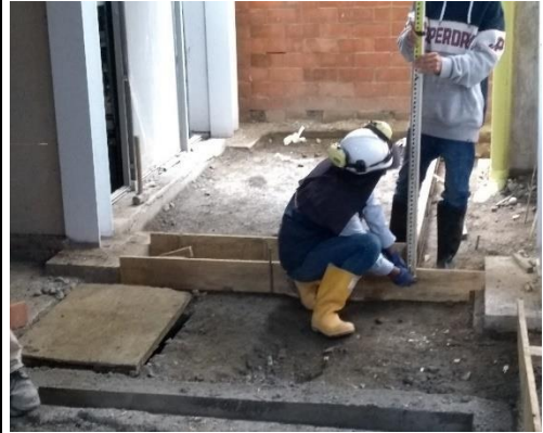
Nivelación de desagües sótanos Fuente: Daniel Tejada
