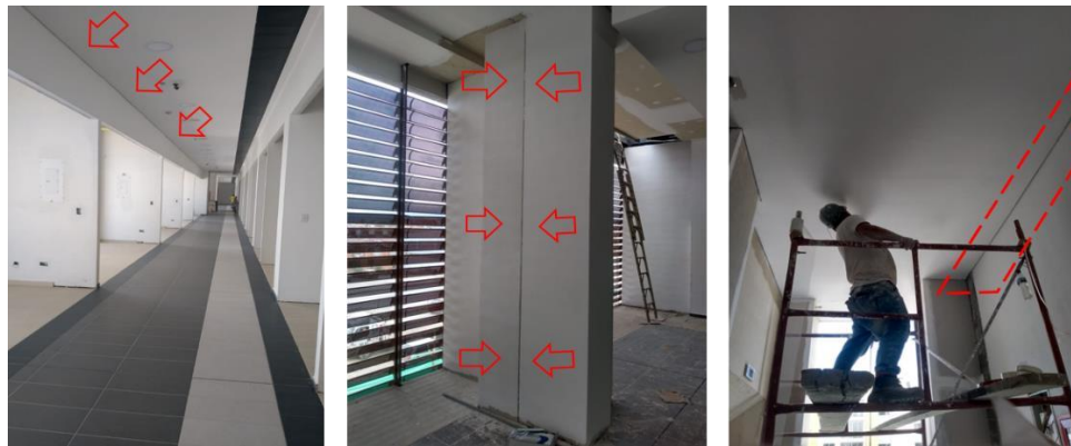
Ilustración 42: Juntas de control estructural
