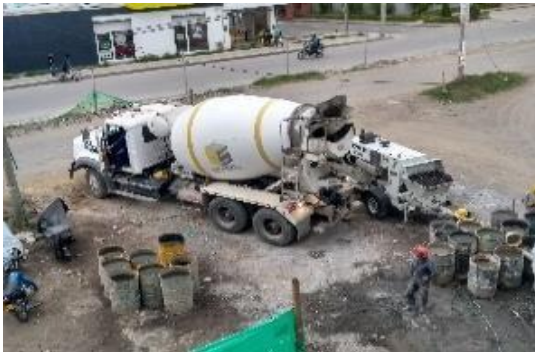
Ilustración 35: Fundición de losa de entepiso de los sótanos
