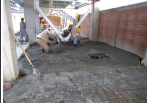
Funicion de losa Sotano. Fuente: Daniel Tejada
