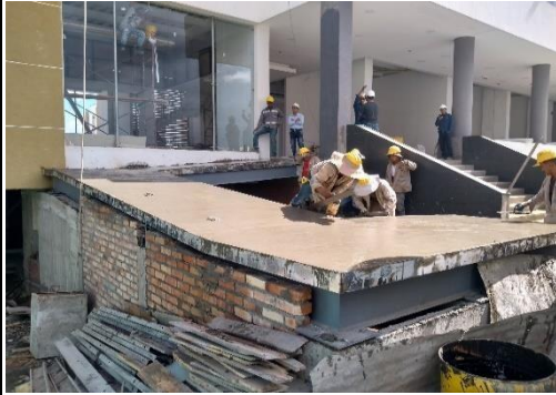
Fundición Rampa Fuente: Daniel Tejada
