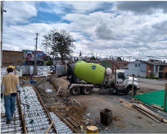
Ilustración 43: Ilustración 38: Fundición de rampas
