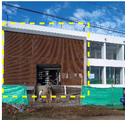
Ilustración 33: Instalación de carpintería metálica en fachada.
