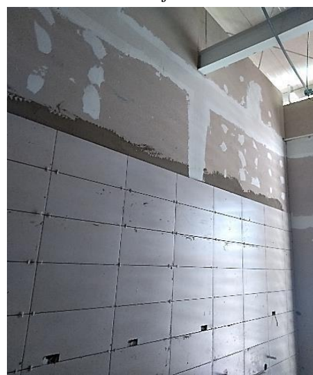
Tratamiento de junta visible
