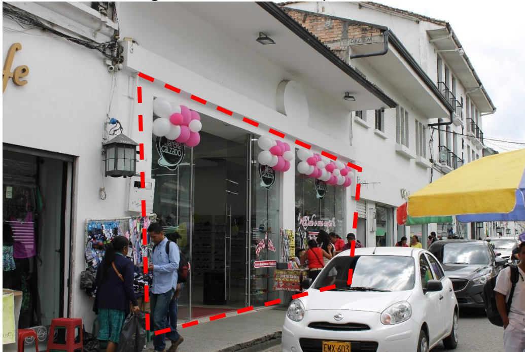
Imagen 27 Afectación fachadas patrimoniales
