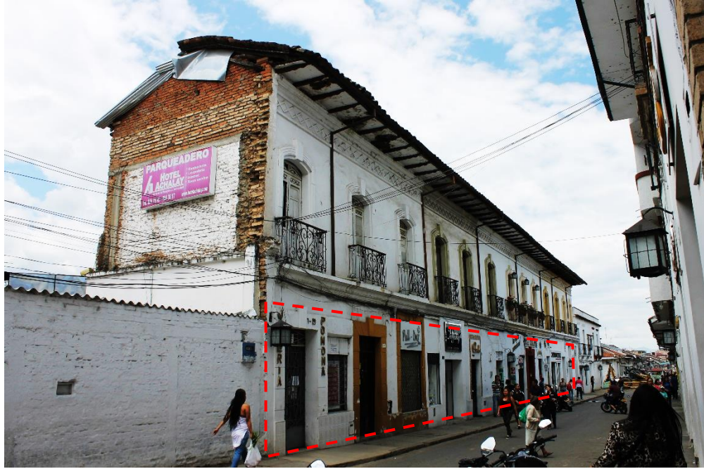
Imagen 28 Afectación fachadas calle 6ta
