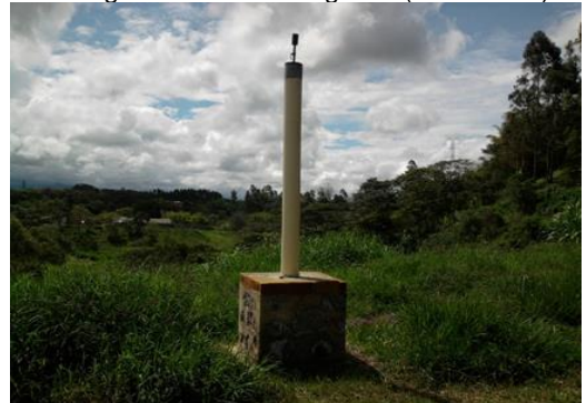
Imagen 8. Emisión de gases (chimeneas)
