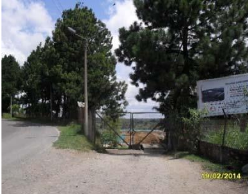
Imagen 20. Acceso principal ex vertedero “El Ojito”
