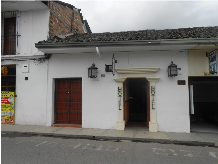
Anexo N Fachada Hotel Alcayata.
