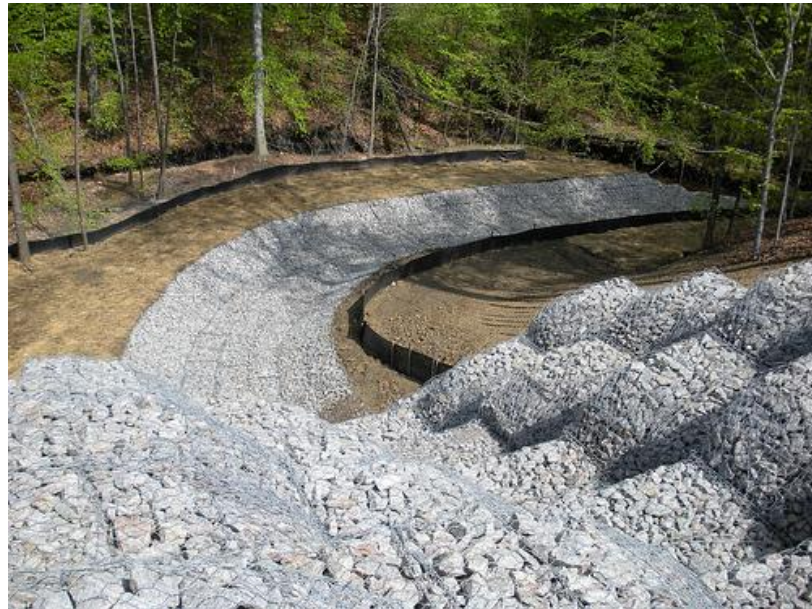
Imagen n° 28 colocación de gaviones
