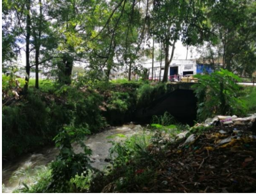
Imagen n° 5 puente carrera 11 Fuente: autoras
