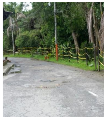
Imagen n° 4 vía inmediatas a la ronda hídrica Fuente: Autoras
