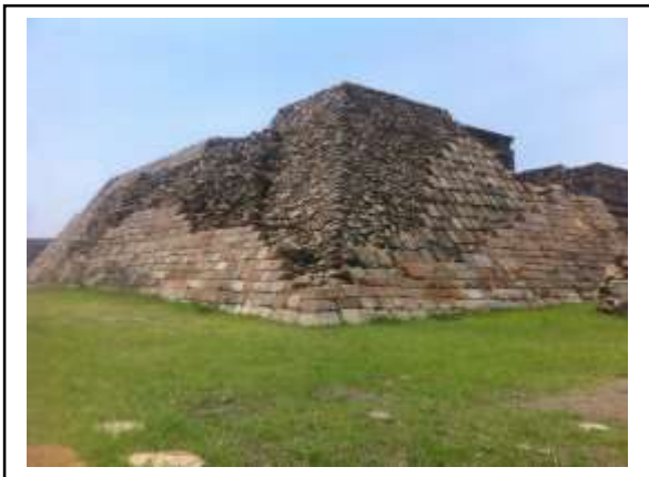
IMAGEN 12 : templo principal sistema constructivo talud tablero FUENTE: propia.
