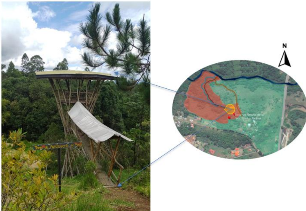
Figura 10. Mirador (estructura en guadua)
