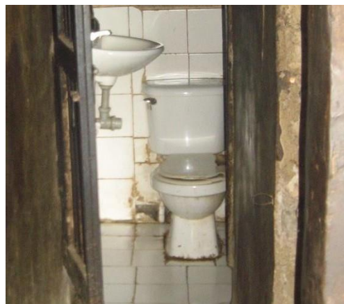
Imagen 113: Baño zona de servicios
