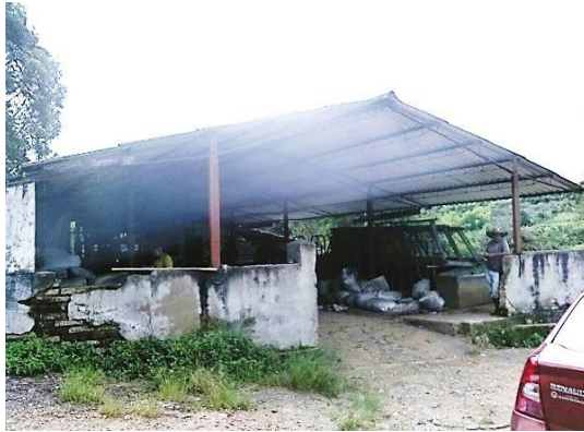
Imagen No.85: Acceso zona de trabajo
