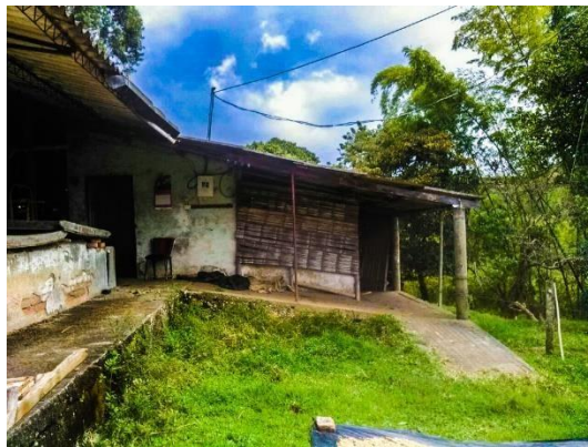
Imagen No.95: Cuarto de maquina secadora
