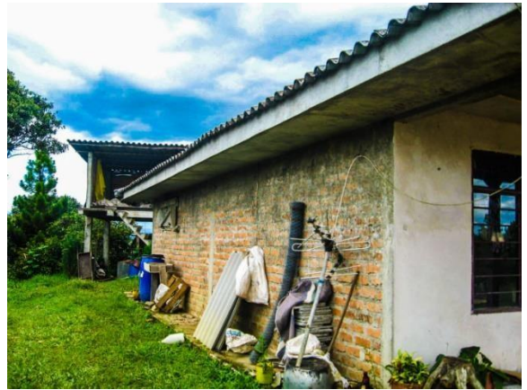
Imagen No.79: Cielo raso con concreto
