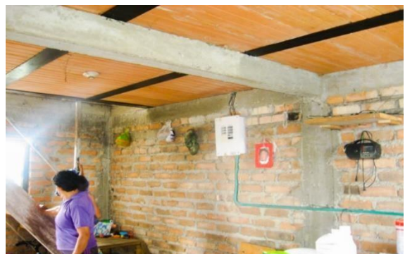
Imagen No.77: Losa de entrepiso en bloquelòn
