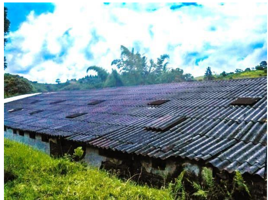
Imagen No.88: Cubierta beneficiadero
