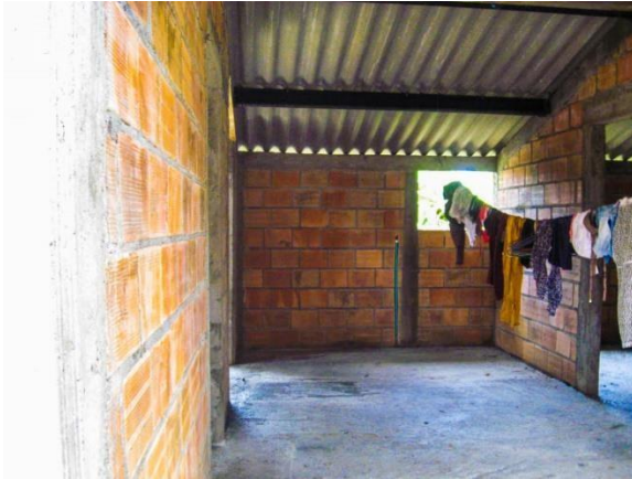
Imagen No.78: Sistema confinado con ladrillo farol
