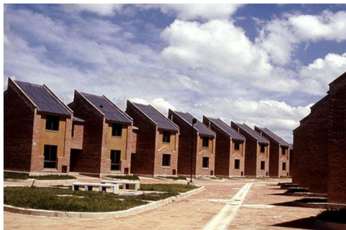
Fotografía 8 Vista del proyecto.
