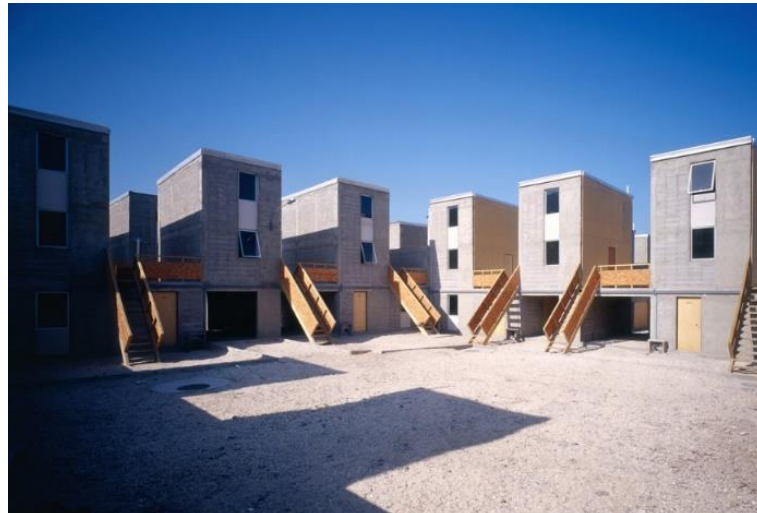
Fotografía 6 Vista del proyecto culminado.
