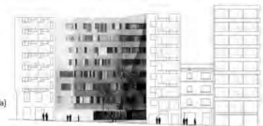
Imagen 16. Buenas prácticas. Edificio de viviendas, guardería y centro cívico (arq. Jordi Badia). Barcelona–España.
