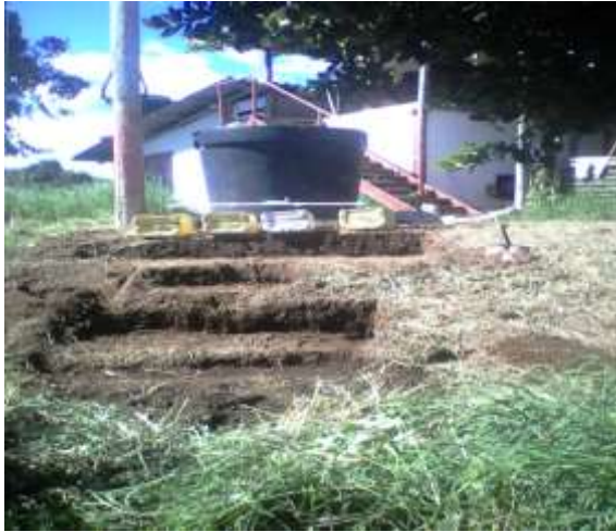
Figura 11. Adecuación del terreno.
