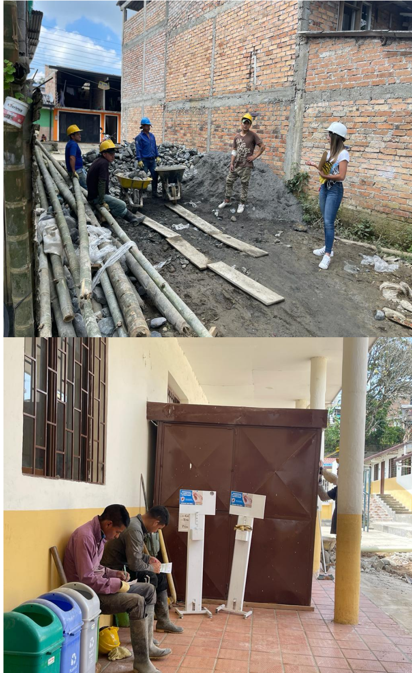
Figura 25.- Evidencia capacitación en medidas de prevención y control de peligros
