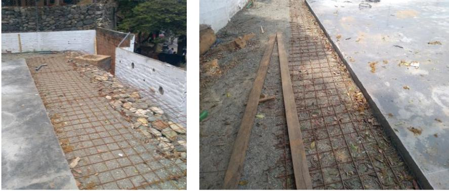
**Ilustración 22. Cimentación – Losa Concreto – Malla Electrosoldada. Fuente: Elaboración propia.**
