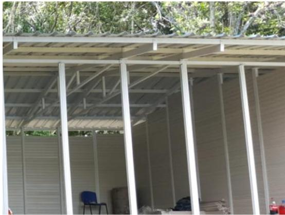
**Ilustración 26. Montaje de Cubierta Teja Trapezoidal. Fuente: Elaboración propia.**
