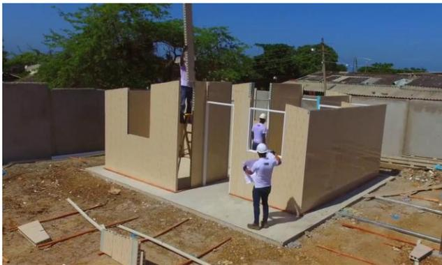
Ilustración 1. Casa Prefabricada en RBS. Tomada de <http://micig.uniandes.edu.co/VIS.jpg>
