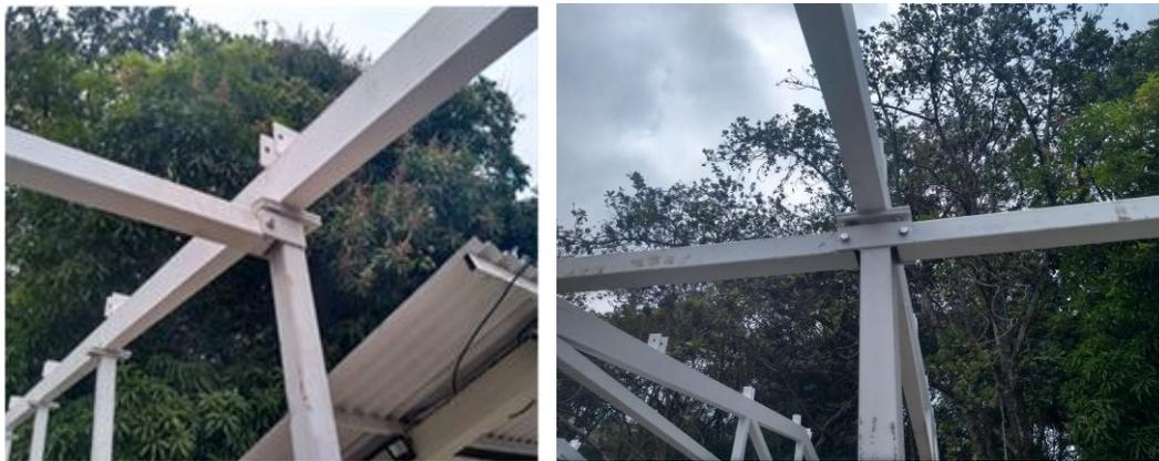
Ilustración 25. Montaje Vigas Amarre Cubierta – Correas. Fuente: Elaboración propia.
