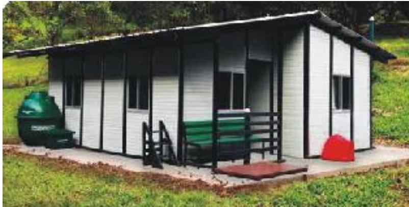
Ilustración 10 Modelo de vivienda rural, el cual se encuentra en fase de estudio y mejoramiento, propuesto por la empresa Intera sas, elaborada en bloques de plástico reciclado. El prototipo se encuentra construido en las instalaciones de la Empresa Intera Sas:(imagen) Elaboración Propia
