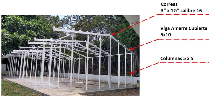
Ilustración 21. Estructura Metálica. Fuente: Elaboración propia.
