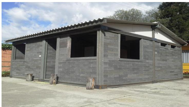
**Ilustración 2. Casa Fabricada en Panel Plástico Reciclado. Tomada de <https://www.archdaily.co/co>**
