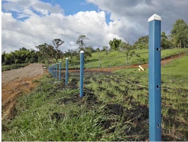
**Ilustración 8 Postes elaborados en plástico reciclado, Cerramiento ubicado en la Planta de desarrollo de desarrollo tecnológico Innovación Sostenible, Intera Sas. Fuente:(imagen) [www.intera.com.co](http://www.intera.com.co)**
