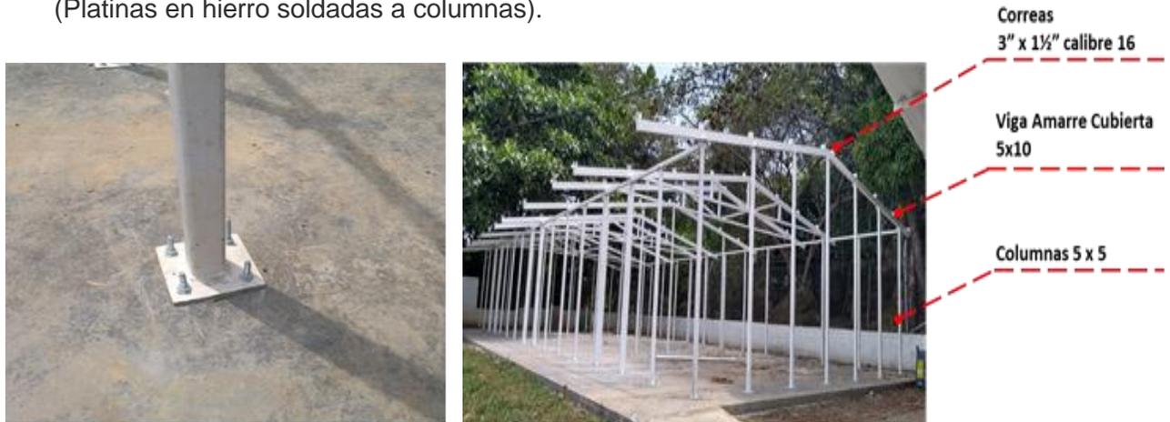
Ilustración 24. Montaje Estructura Losa cimentación. Fuente: Elaboración propia.
