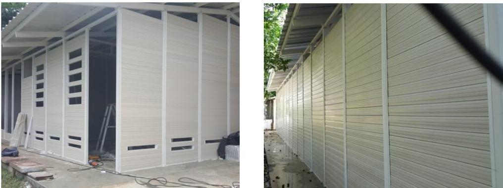
**Ilustración 27. Instalación Muros Perimetrales - Perfil plástico extruido (PEAD – Polietileno de alta densidad) Fuente: Elaboración propia.**
