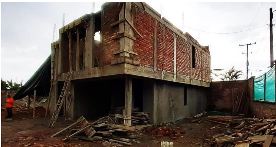
Vivienda tipo terminada en obra negra.
