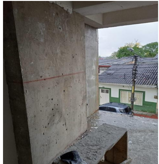
Estructura muro pantalla.
