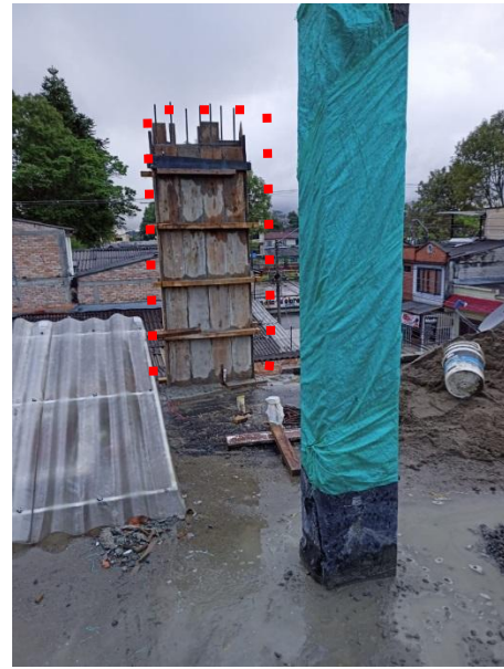
Imagen. cambio de dimensión en columna en tercer piso las cuales no se muestran en el plano.
