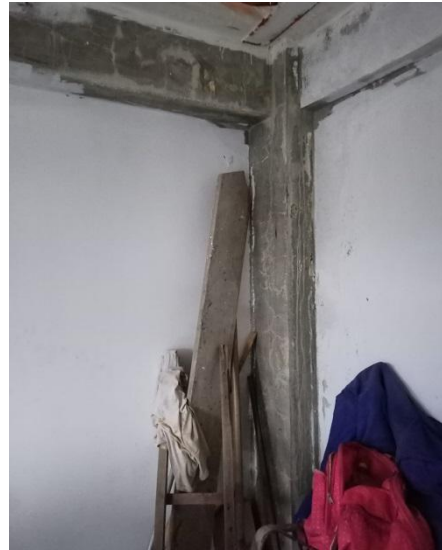
Imagen. cambio de dimensión en columna en tercer piso las cuales no se muestran en el plano.
