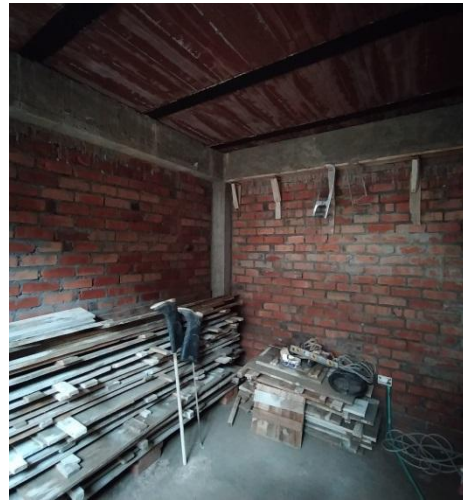
Espacios construidos (estructura aporricada y losa aligerada en bloquelon).
