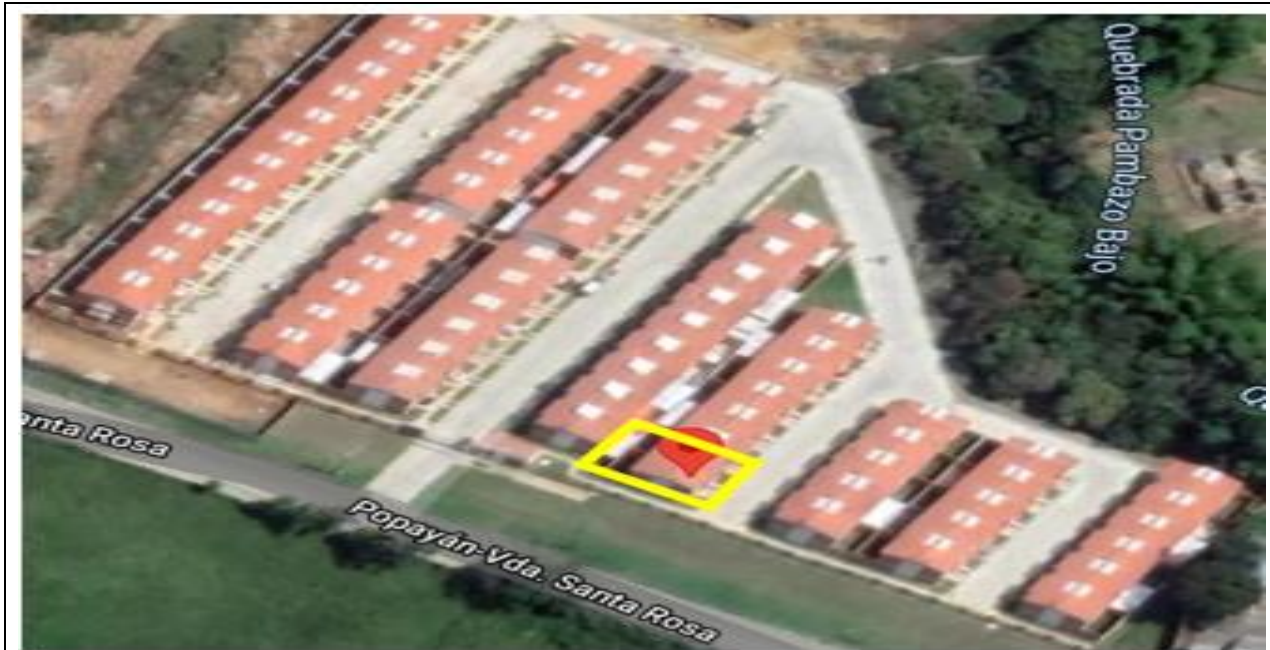
Ubicación predio: Imagen. Fuente: Google Earth
