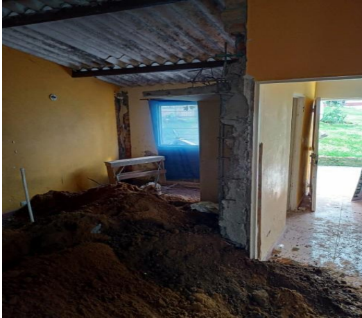
Imagen . demolicion de pisos para zapata determinadas según plano que esta siendo aprobado por curad
