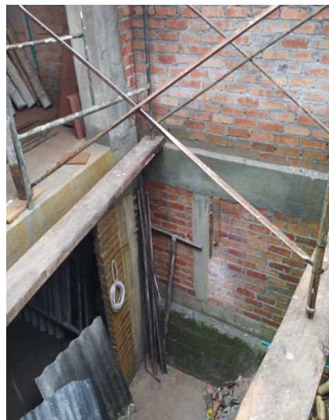
Vacío de iluminación y ventilado naturalmente.
