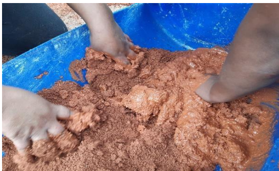
FOTO 27: proceso del amasado del barro tradicional con los estudiantes. Fuente propia.
