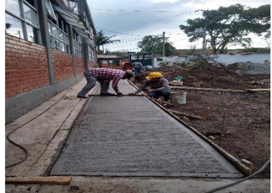
Fotografía 68. Fundición de andén
