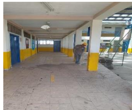
Fotografía 36. Aseo general de la obra.
