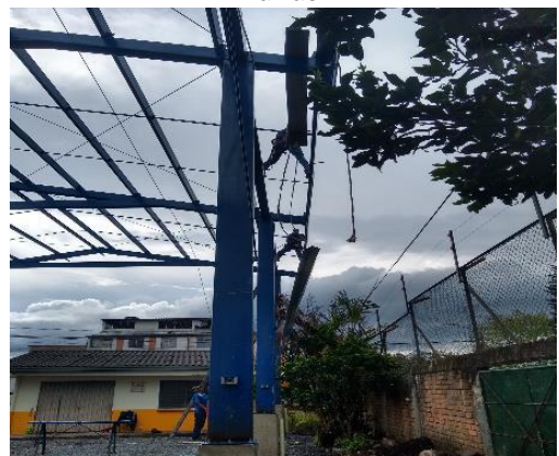
Fotografía 56. Instalación canal de aguas lluvias
