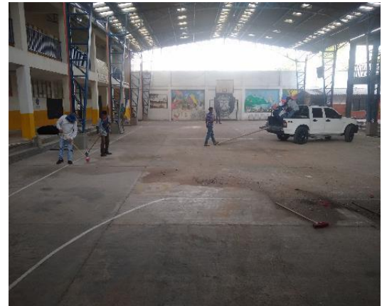
Fotografía 70. Limpieza de la cancha existente.
