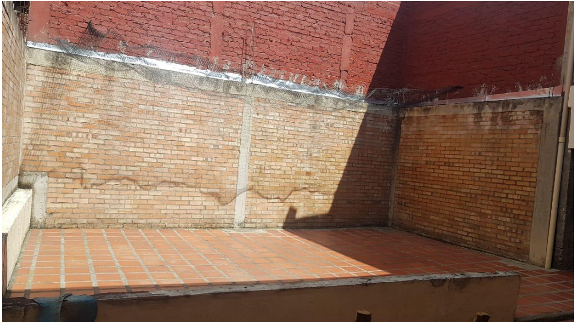
Fotografía 9. Patio de atrás de la Institución
