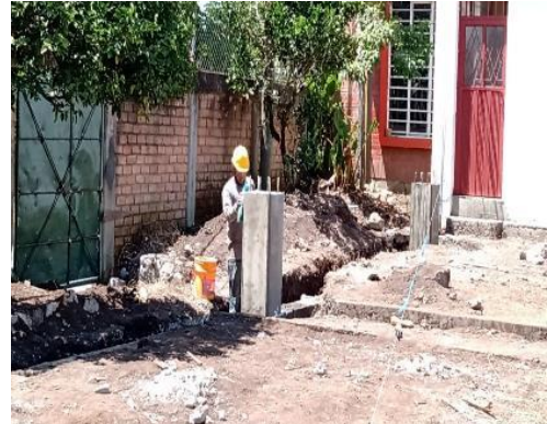
Fotografía 34. Aplicación de antisol para columnas
