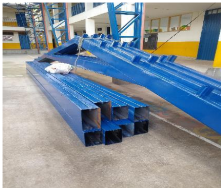
Fotografía 35. Cerchas y columnas de estructura metálica
