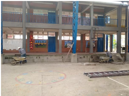
Fotografía 67. Limpieza y descolmatación, cajas de aguas lluvias.
