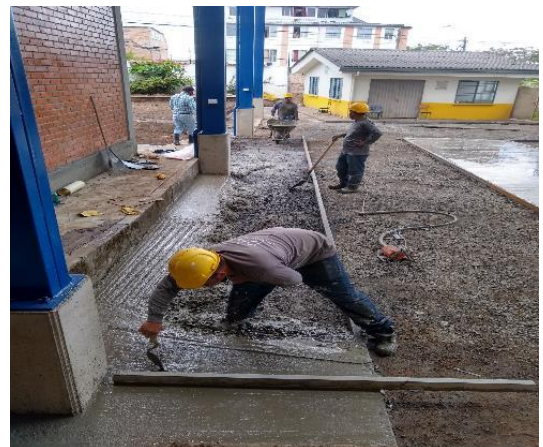
Fotografía 66. Vaciado de concreto para placa de concreto
