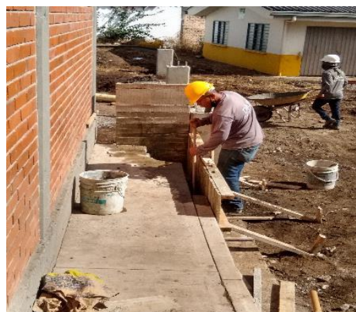
Fotografía 40. Recalce de bordillo y andén
