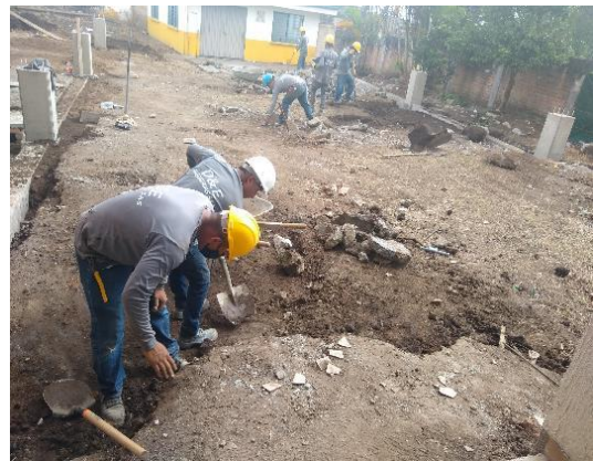
Fotografía 38. Excavación de material común
