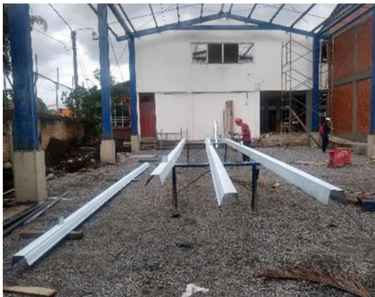
Fotografía 55. Pintura canal de aguas lluvias
