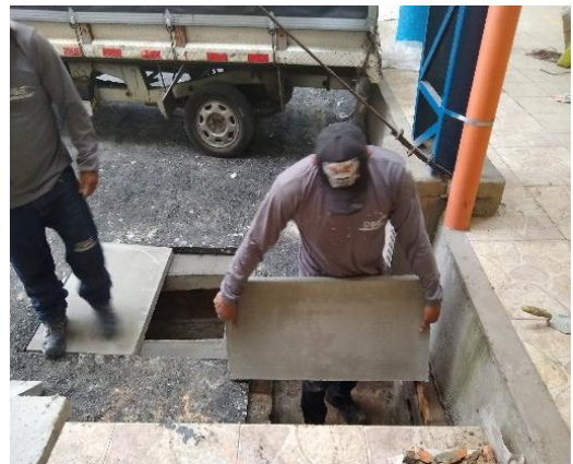
Fotografía 85. Instalación de las tapas en concreto para cajas de aguas lluvias
