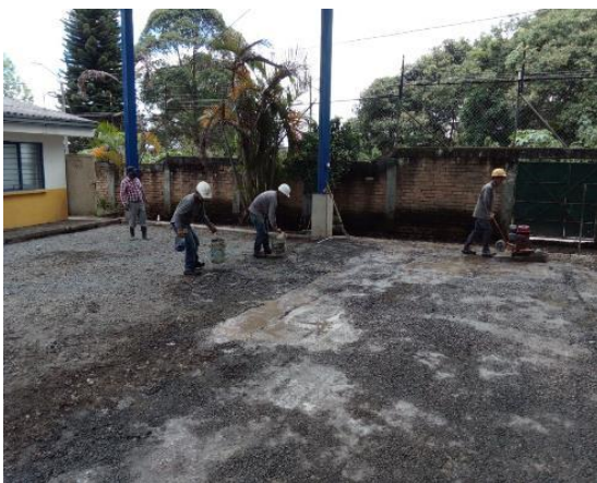
Fotografía 65. Compactación de base granular
