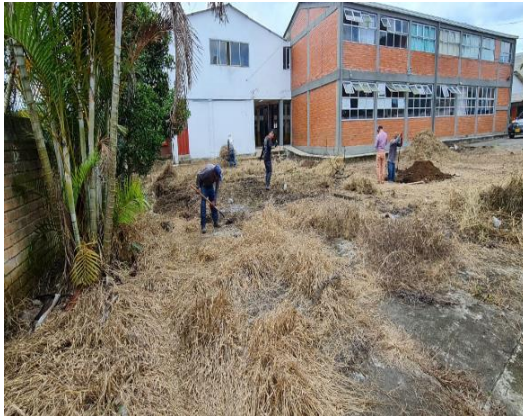
Fotografía 18. Descapote y limpieza del terreno
