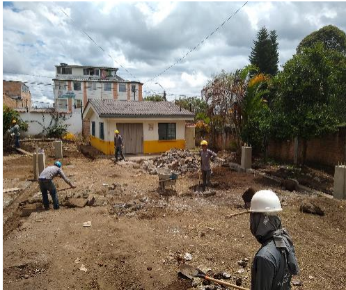
Fotografía 37. Demolición de concreto existente
