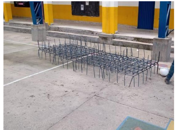
Fotografía 19. Acero de refuerzo zapatas
