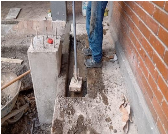
Fotografía 39. Recalce de bordillo y rampa
