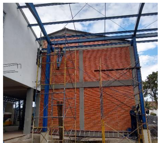
Fotografía 58. Instalación de reflectores
