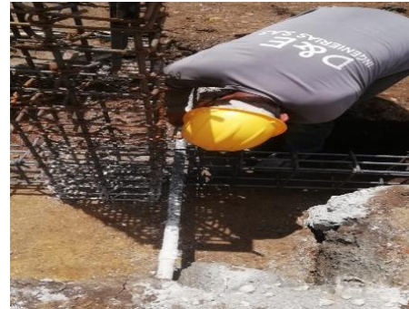
Fotografía 32. Arreglo de tubería de agua potable
