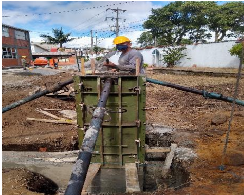
Fotografía 33. Encofrado, apuntalado y vaciado de columnas
