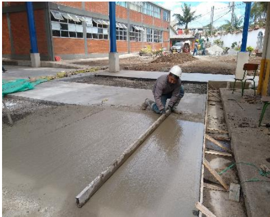
Fotografía 69. Construcción de placa de concreto
