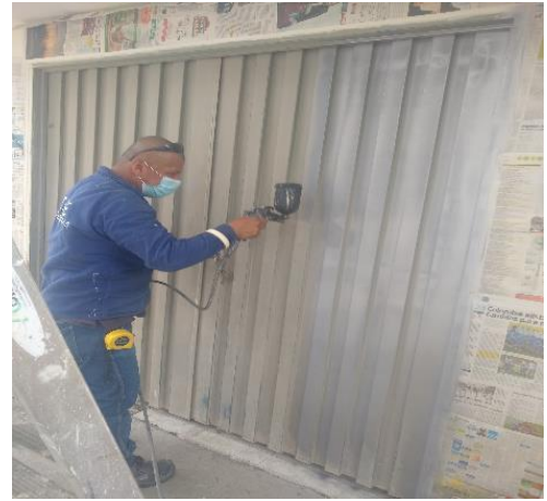
Fotografía 83. Pintura puerta metálica
