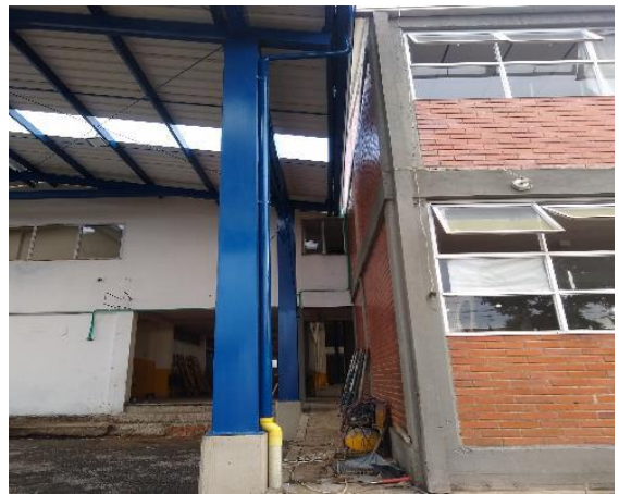
Fotografía 64. Instalación de bajante de aguas lluvias
