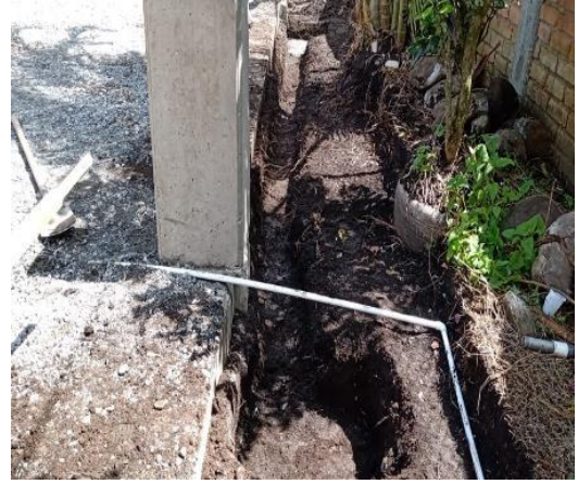
Fotografía 46. Excavación para tubería de agua lluvia
