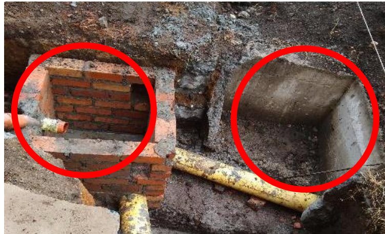
Fotografía 24. Demolición y construcción caja de inspección de aguas lluvias
