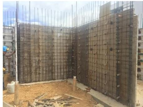
**Ilustración 67: modulación de paneles forsa.**
