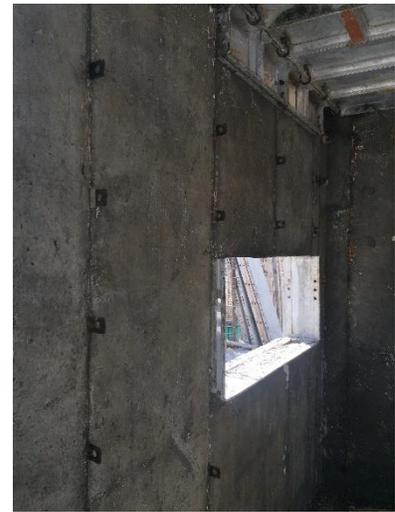
**Ilustración 76, 77 y 78: retiro de paneles (76), desencofrado de muros en esquina (77), superficie desencofrada con corbatas y elemento de ventana (78).**
