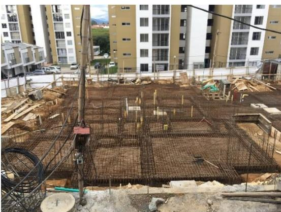
**Ilustración 51:** instalación de elementos para arranque de muros.
