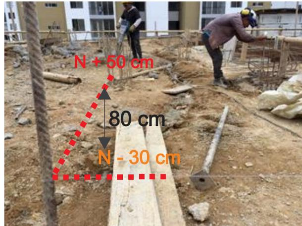
**Ilustración 37: ubicación del nivel 0.0 y +50.** **Ilustración 38: trazo de nivel +50, inicio de nivelación**
