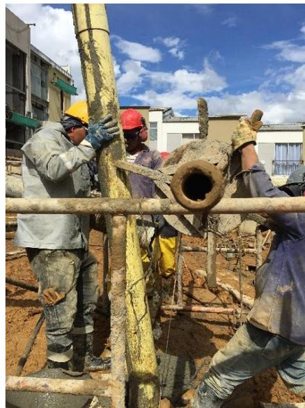
**Ilustración 34: retiro de tubos de fundición.**
