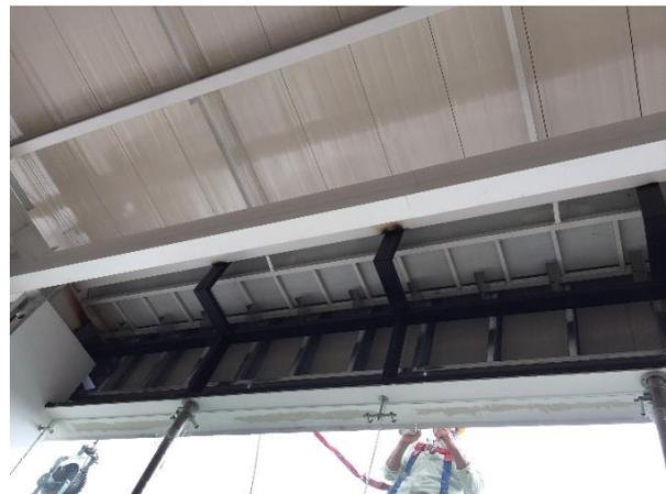
**Ilustración 84: Estructura metálica en dinteles de fachada**
