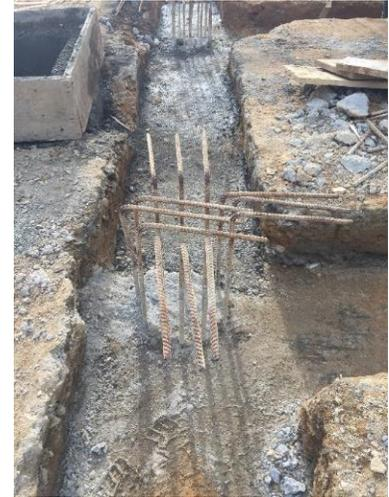
**Ilustración 41, 42 y 43: excavación de viga z1, conexión a pilotes.(41), tratamiento de arranques(42), arranques de pilotes figurados. (43).**
