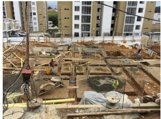
**Ilustración 48:** rectificación de niveles, medidas del planteo y excavación de vigas
