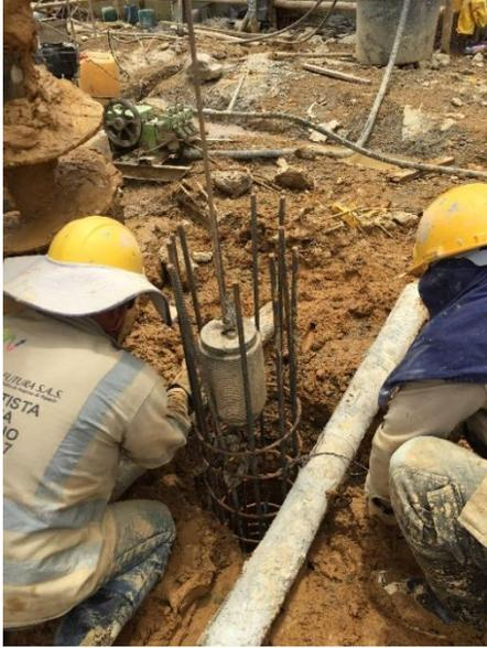
**Ilustración 23: ubicación y centralización del castillo.**
