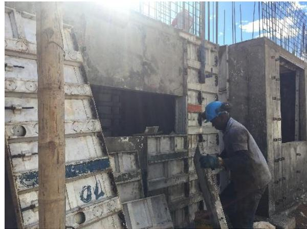
**Ilustración 80: desencofrado de paneles externos.**
