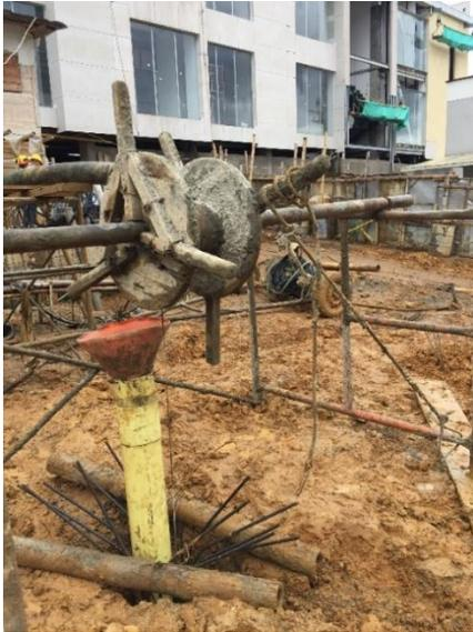
**Ilustración 31: tubos de fundición introducidos, colocación de embudo, aseguramiento del yoyo.**
