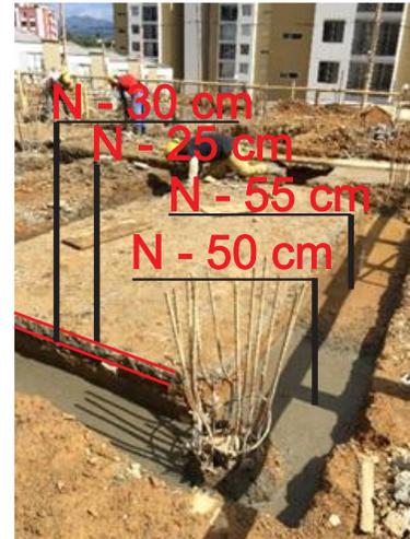
**Ilustración 39: terreno nivelado.**
