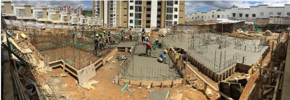
**Ilustración 54: Fundición y nivelación de losa.**
