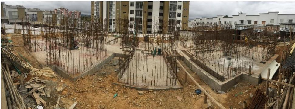
**Ilustración 56: losa desencofrada, armado elementos de muro primer piso.**
