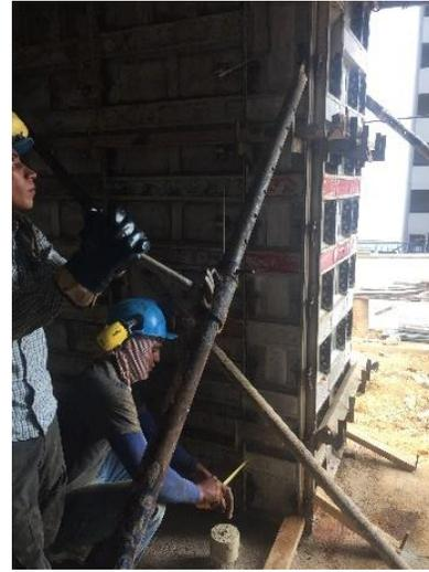
**Ilustración 72: Ajuste de plomos.**
