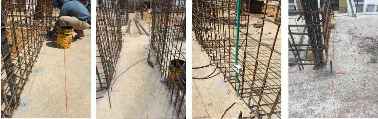
**Ilustración 59, 60, 61 y 62: Perforación de losa con taladro(59), topes de acceso apto 101(60), distancia entre pines o topes (61), tope esquinero en segundo piso (62).**
