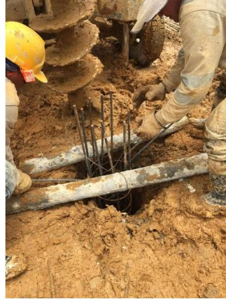
**Ilustración 24: fijación del castillo, doblaje de varillas sobresalientes**
