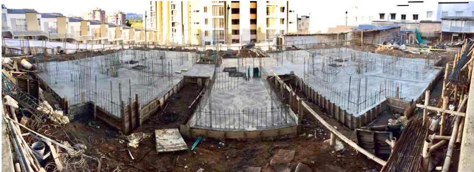
**Ilustración 55: humectación de losa**
