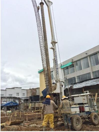
**Ilustración 19: enganche y elevación de castillo 1.**
