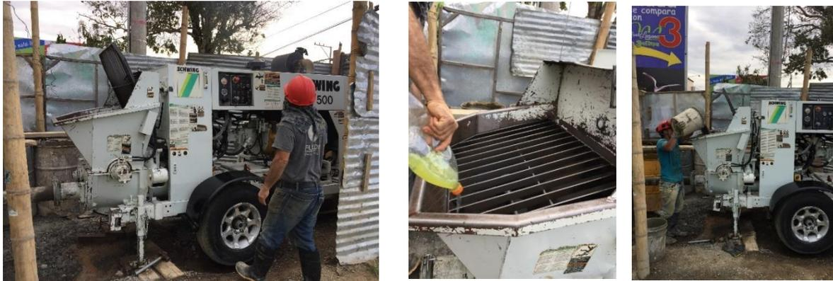
**Ilustración 25, 26 y 27 : preparación de bomba. (25), aplicación acmp en tolva (26), aplicación ceba (27).**
