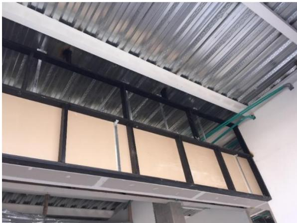
**Ilustración 83: estructura metálica en dinteles de locales.**
