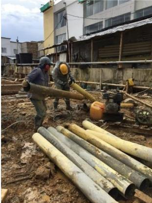
**Ilustración 35: limpieza de tubería de fundición.**
