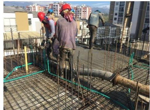
**Ilustración 73, 74 y 75: Armado de tubería para envío de concreto (73), Inicio de fundición losa y muros (74), Movilización de tubos para esparcimiento de concreto(75).**
