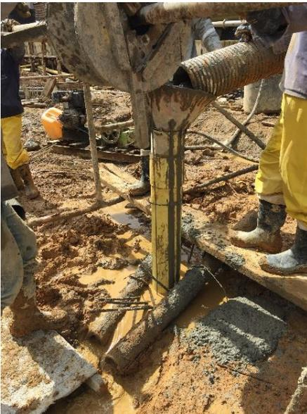
**Ilustración 33: inicio de fundición.**
