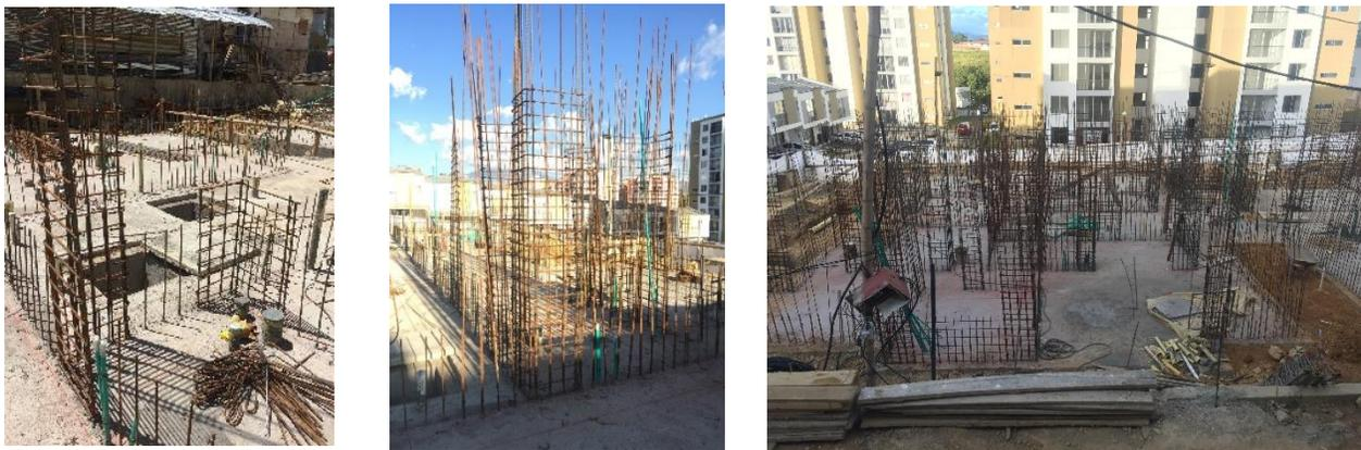
**Ilustración 63, 64 y 65: inicio de amarre elementos de muro (63), elementos de muro armados en apto 101 (64), avance de elementos de muro primer piso. (65).**
