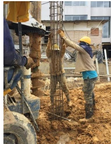
**Ilustración 20, 21 y 22 : Enganche de castillo 2 (20), elevación de castillo 2 (21), traslapeo castillo 1 con castillo 2 (22).**
