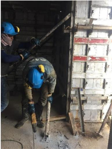
**Ilustración 71: Instalación y fijación de gato tensor.**
