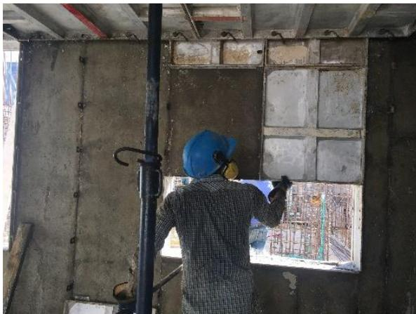
**Ilustración 79: desencofrado de paneles internos.**
