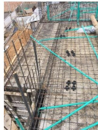
**Ilustración 68, 69 y 70: inicio modulación de losa (68), fijación de paneles de losa (69), detalle armado losa(70).**
