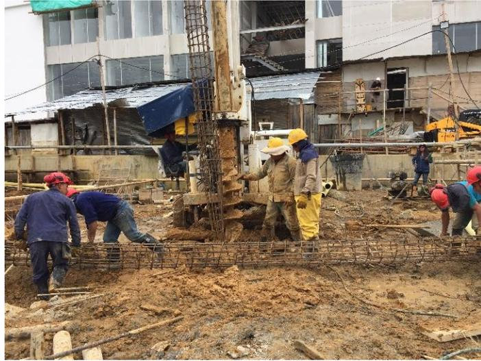
**Ilustración 20: inmersión de castillo 1 en perforación**
