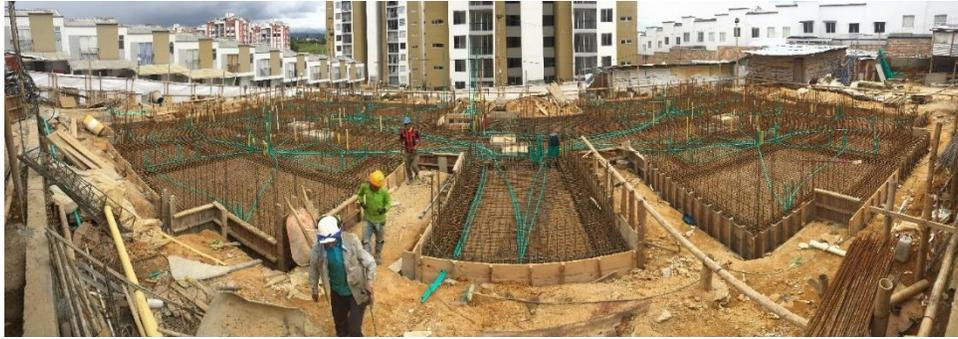
**Ilustración 53: Encofrado, limpieza de losa y armado de tubería.**
