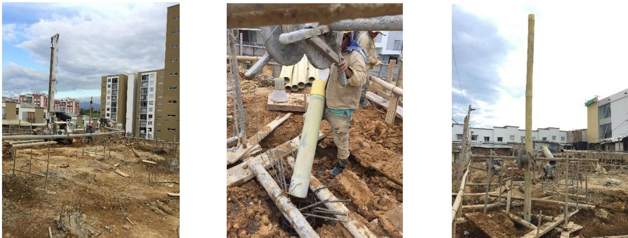
**Ilustración 28, 29y 30: armado de tubería para envío de concreto. (28), introducción de primer tubo de fundición (29), tubos de fundición para introducir (30).**
