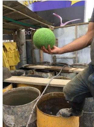
**Ilustración 36: Esponja para limpieza de tubería de envío de concreto**
