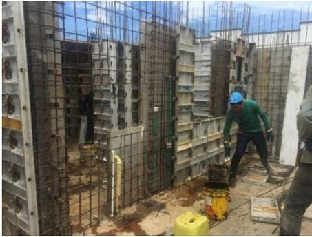
**Ilustración 66: acondicionamiento de paneles.**
