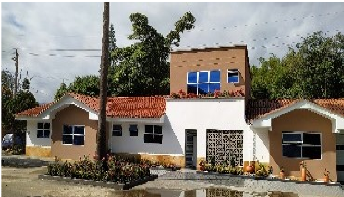
Registró fotográfico 16 fachadas - fuente: propia
