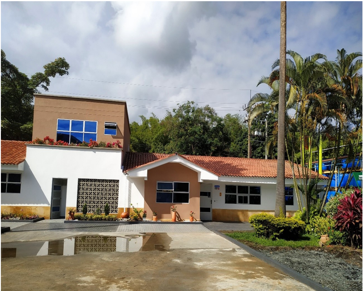
Registró fotográfico 8 fachadas - fuente: propia
