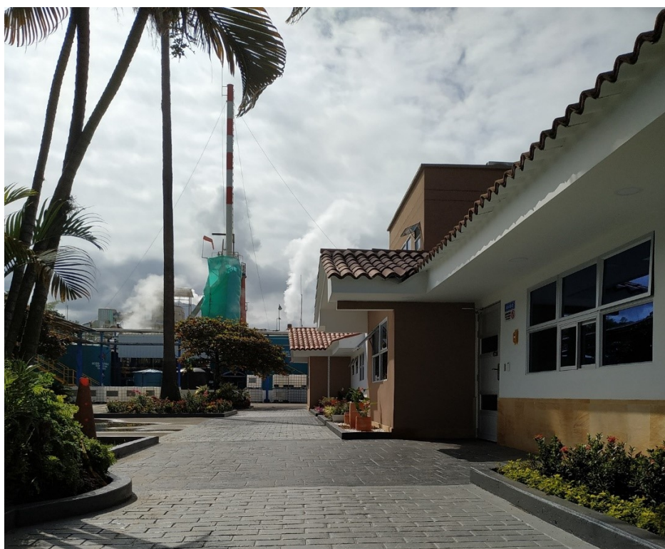
Registró fotográfico 10 fachadas - fuente: propia
