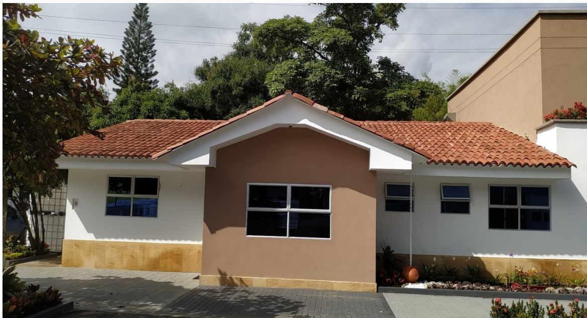
Registró fotográfico 9 fachadas -fuente: propia
