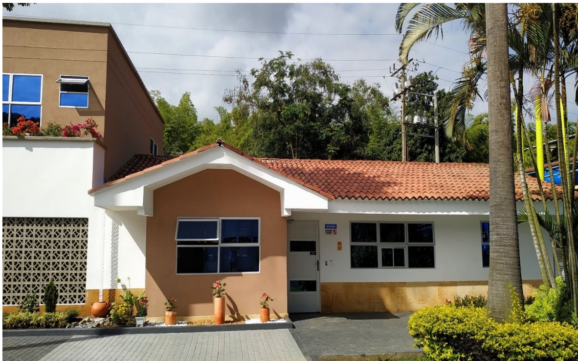
Registró fotográfico 15 fachadas - fuente: propia
