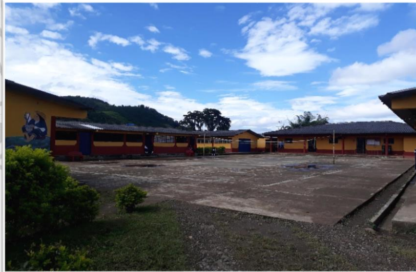
Ilustración 25. Aulas de clase de la sección primaria en la Institución Educativa Agroindustrial La María Piendamó.
