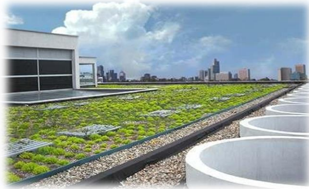
Ilustración 17. Cubierta verde edificio Novatris. Primer edificio con certificación leed en Colombia
