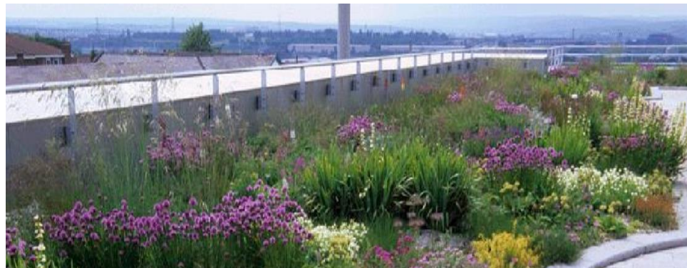
Ilustración 22. Techo verde semi-extensivo del Moorgate Crofts Business Centre de Rotherdam , Reino Unido
