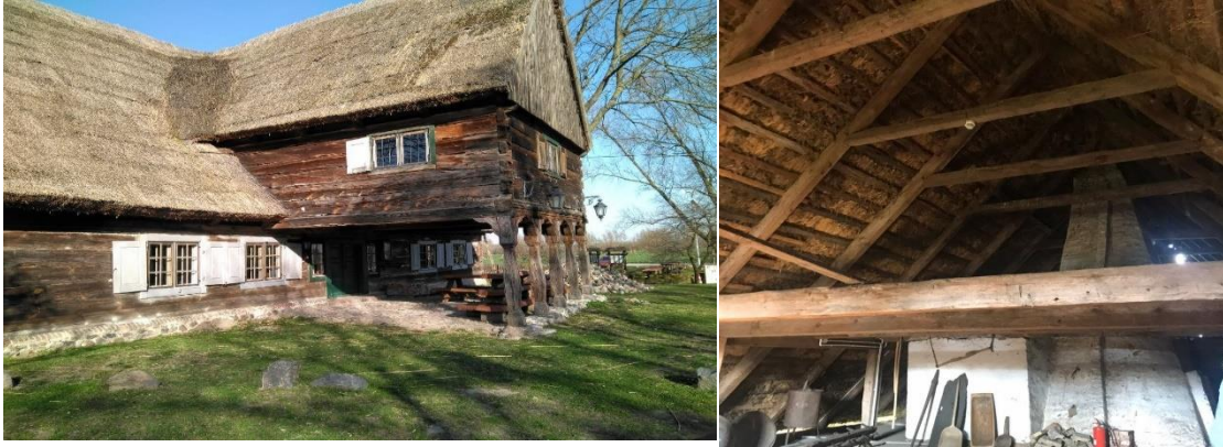
Ilustración 8. Estructura cubierta Chata
