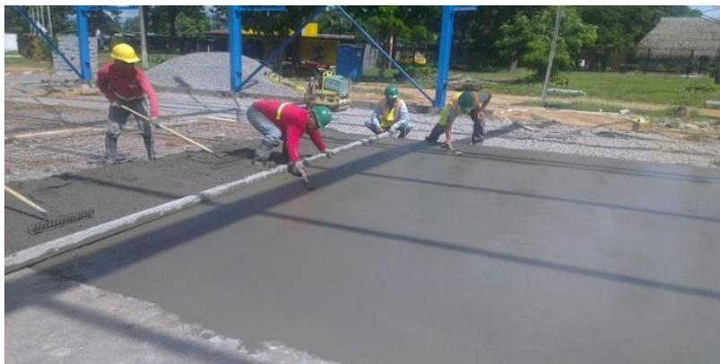
Figura 58. Referente de losa de piso con acabado de quema de cemento. **Fuente:** adaptado con investigación de: (Arquitectura Civil.Blog, 2019).
