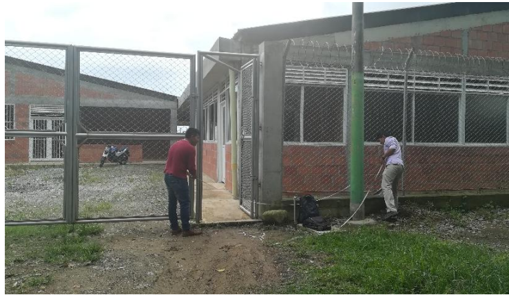
Foto 08. Levantamiento arquitectónico de exteriores del “Centro Vida”
