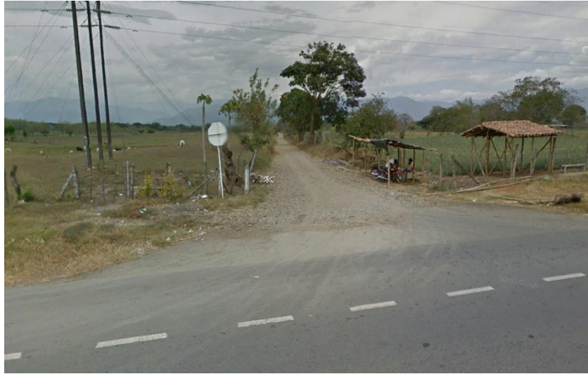
Fotografía 8 estado de la vía
