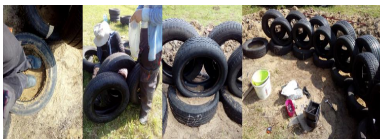
Ilustración 30. Inicio de construcción de muros,. Elaboración propia, 2019.
