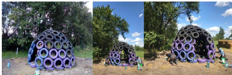
Ilustración 37. Estructura subdivisoria, acondicionamiento interior e instalación de cañizo. Elaboración propia, 2019.
