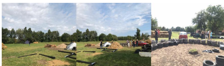
Ilustración 46. Inicio de formación de estructura y promoción de bioconstrucción. Elaboración propia, 2019.
