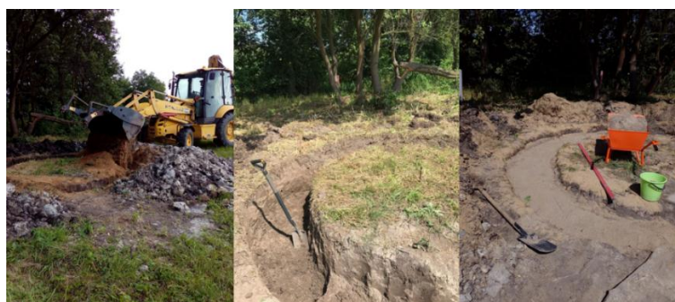
Ilustración 24. Tratamiento de suelo para control de humedad y compactación de suelo donde se dispone la cimentación. Elaboración propia, 2019.
