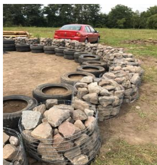
Ilustración 42. Instalación dentro de la circunferencia correspondiente al área del proyecto de bases que forman la cimentación. Elaboración propia, 2019.
