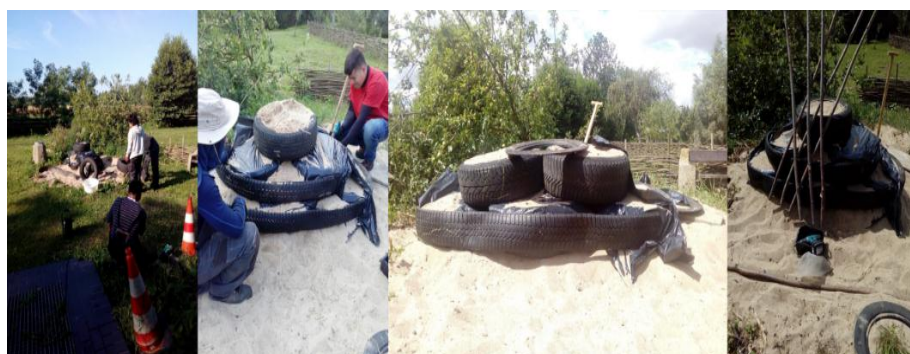
Ilustración 24. 2da parte de experimento.. A fin de evaluar resistencia, tiempo de ejecución y propuesta de revestimiento verde (formación de materas en el muro y estructura para plantación de hiedra). Elaboración propia, 2019.
