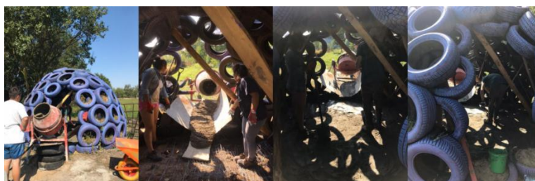
Ilustración 35. Ejecución de cimentación. Elaboración propia, 2019.
