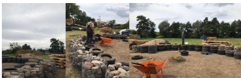
Ilustración 45. Vaciado de tierra para las bases de neumático. Elaboración propia, 2019.
