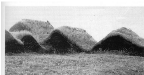
Ilustración 12. Casas tradicionales de panes de césped - Islandia, por techos verdes – Arq. Gernot Minke. Archivo particular correspondiente a recopilación de documento de editorial fin del siglo, techos verdes, construcción experimental, universidad de kassel Alemania 1980.
