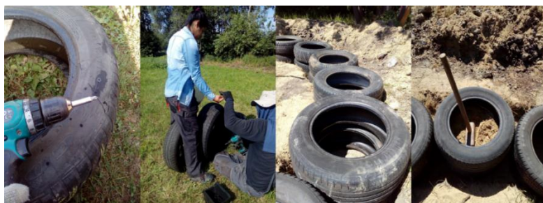
Ilustración 29. Inicio de cimentación,. Elaboración propia, 2019.
