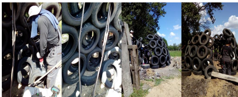
Ilustración 32. Terminación de muro, Para el logro de la construcción fue necesario disponer de unos apoyos (ramas de un árbol corta viento muy típico en la zona). Elaboración propia, 2019.
