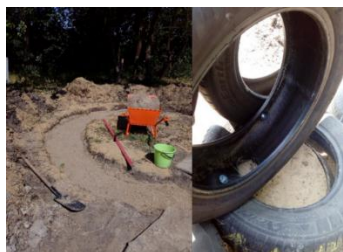
Ilustración 49. Proyecto center space, cimentacion. Elaboración propia 2019.
