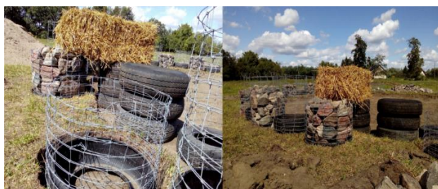
Ilustración 42. Instalación dentro de la circunferencia correspondiente al área del proyecto de bases que forman la cimentación. Elaboración propia, 2019.
