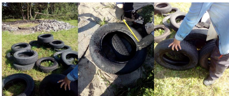
Ilustración 26. Clasificación de material, por tamaño y espesor. Elaboración propia, 2019.
