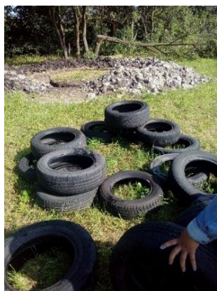
Ilustración 48. Proyecto center space, preparacion terreno. Elaboración propia 2019.
