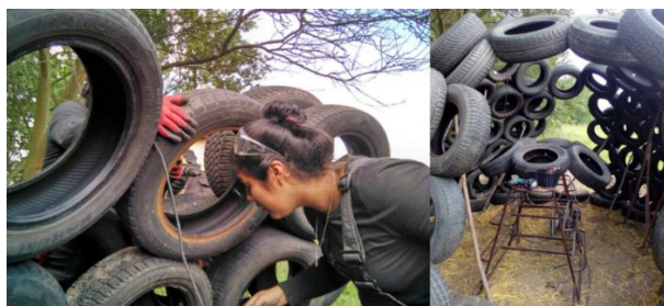
Ilustración 33. Construcción de cubierta. Elaboración propia, 2019.
