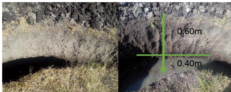
Ilustración 22. Evaluación humedad, capilaridad e inicio de la excavación del proyecto. Elaboración propia, 2019.
