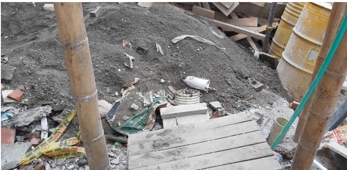
Imagen 24.Sitio de almacenamiento de RCD.
