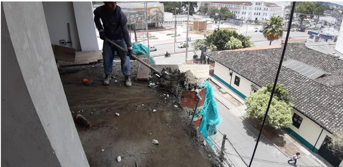
Imagen 36. Deposito de materiales en ducto de bajada de RCD.
