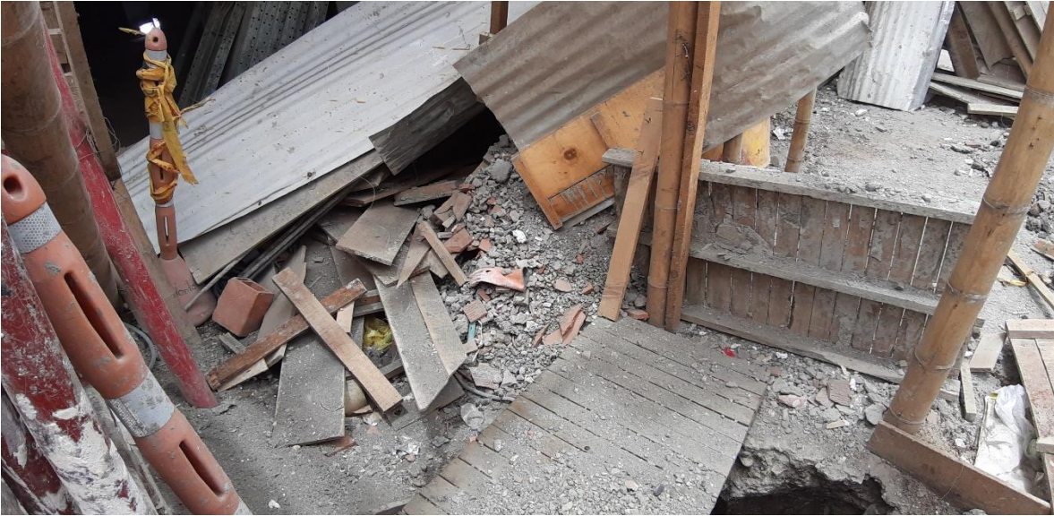
Imagen 27.Sitio de almacenamiento de RCD.
