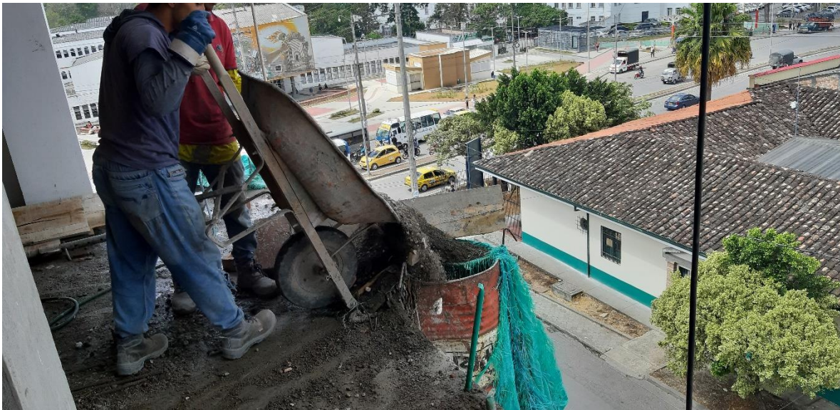
Imagen 35. Deposito de materiales en ducto de bajada de RCD.
