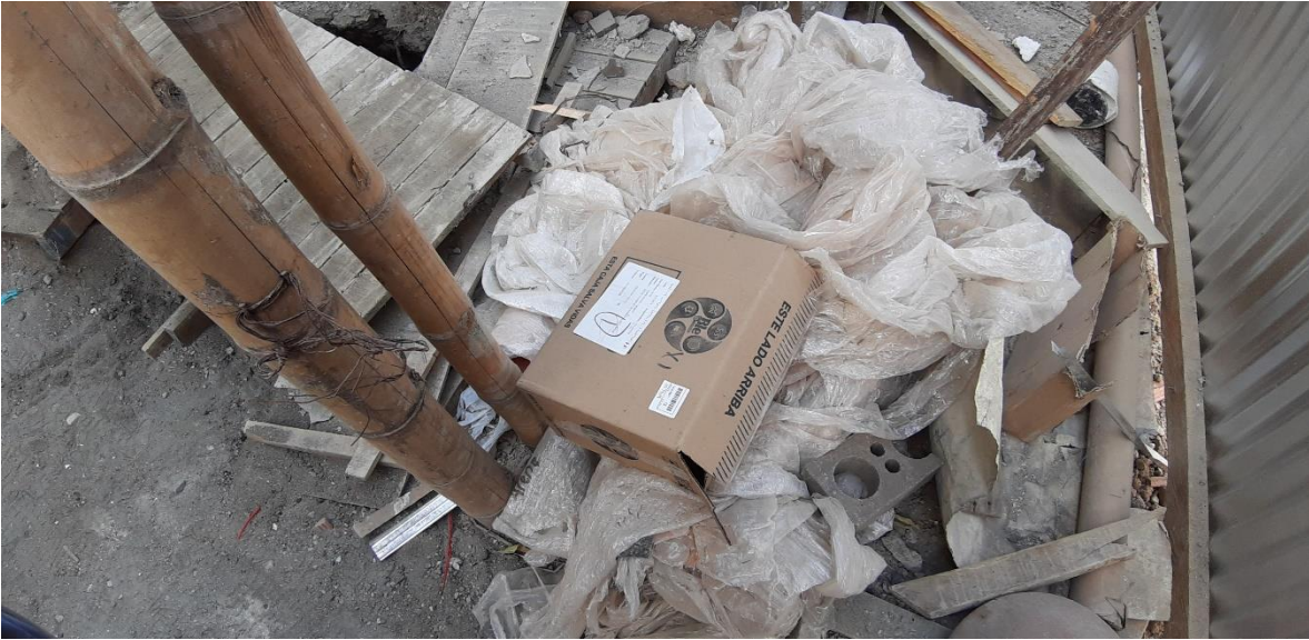
Imagen 31.Sitio de almacenamiento de RCD.
