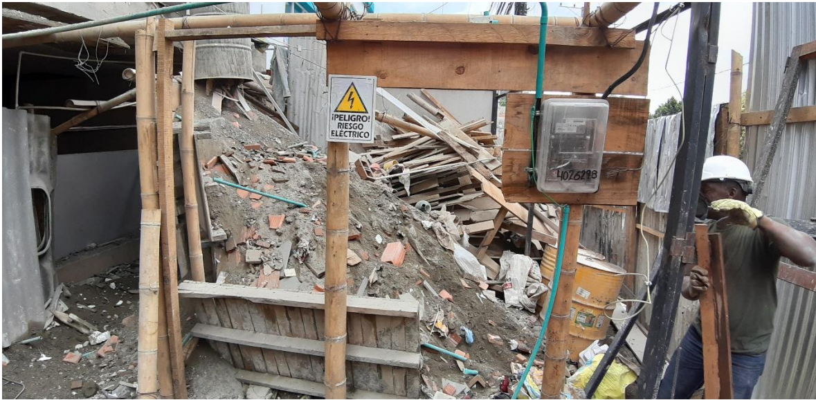
Imagen 23.Sitio de almacenamiento de RCD
