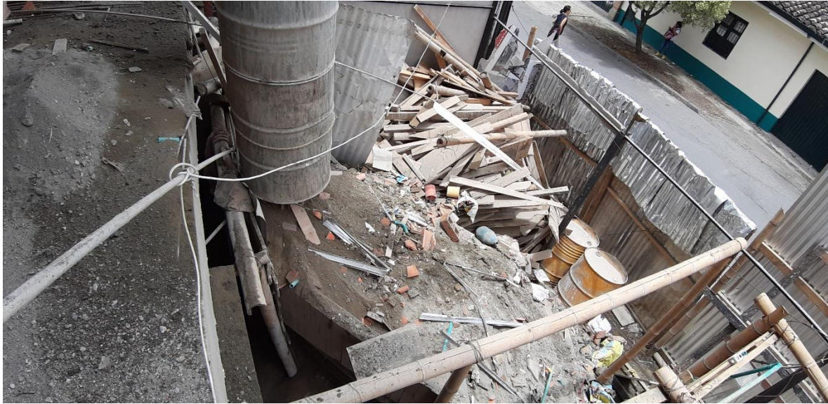
Imagen 39. Ducto de bajada y sitio de almacenamiento de RCD.
