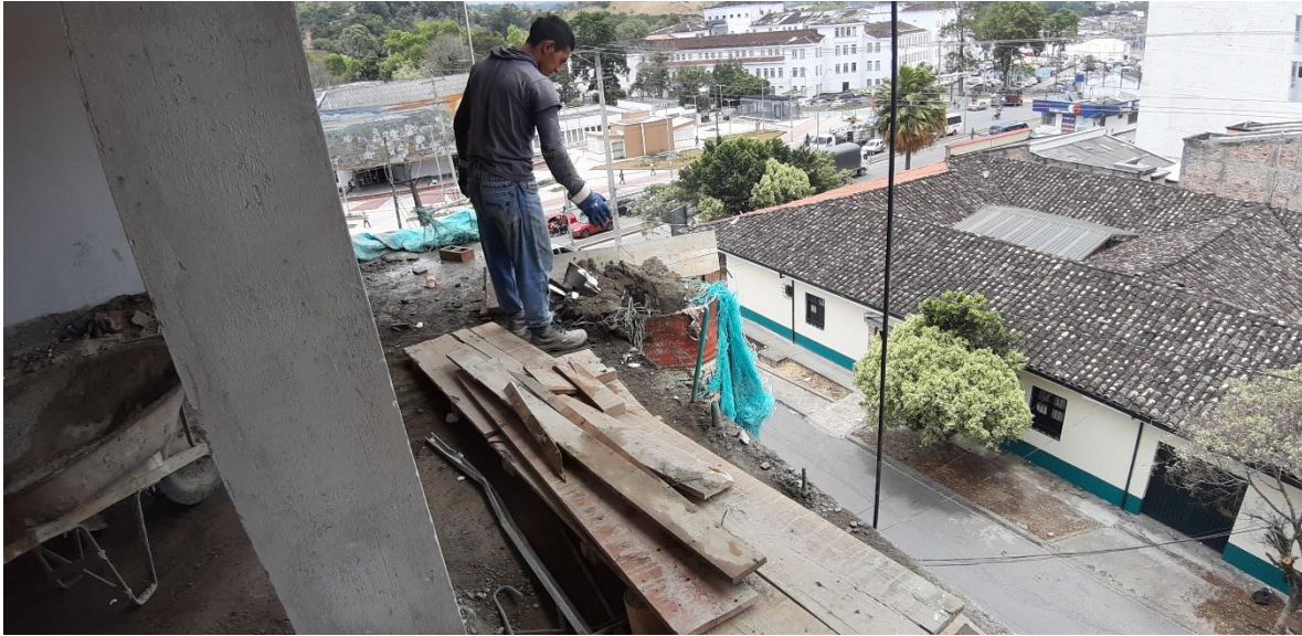
Imagen 37. Deposito de materiales en ducto de bajada de RCD.
