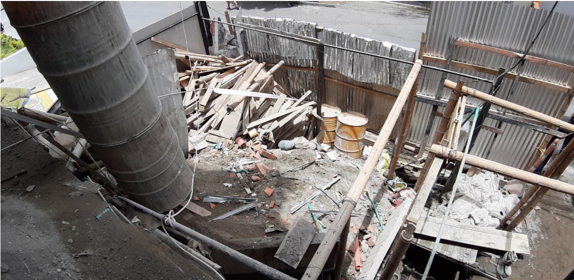
Imagen 22. Ducto de bajada de escombros fabricado en obra.
