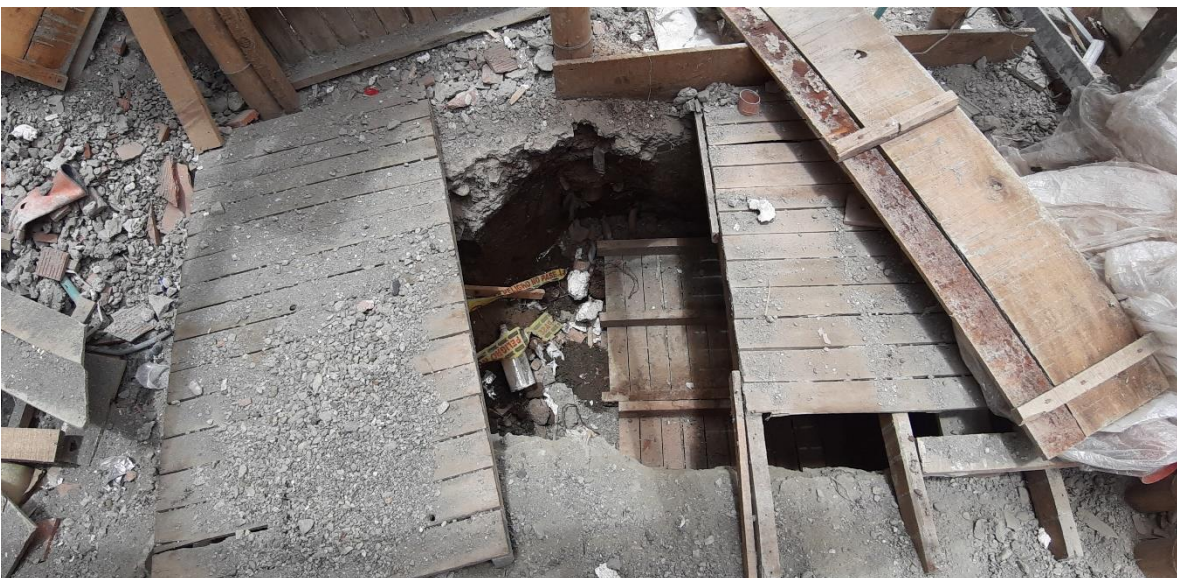
Imagen 28.Sitio de almacenamiento de RCD.
