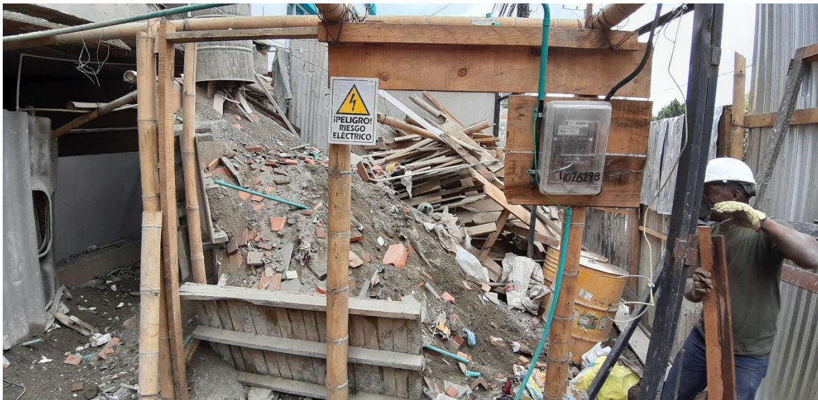
Imagen 32.Sitio de almacenamiento de RCD.
