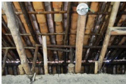
Foto 17: Detalle interior de cubierta de una V1G
