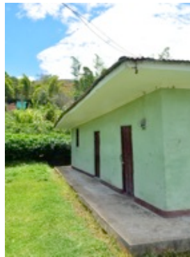
Foto 15: Vivienda Medina Primera Generación V1G
