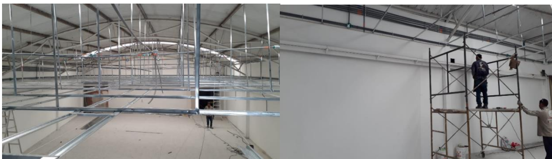
figura 16. Avance de estructura dry Wall Fuente: Elaboración propia
