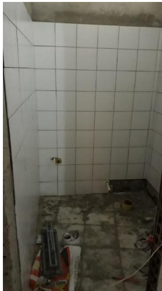
figura 12. Enchape muro baños Fuente: Elaboración propia
