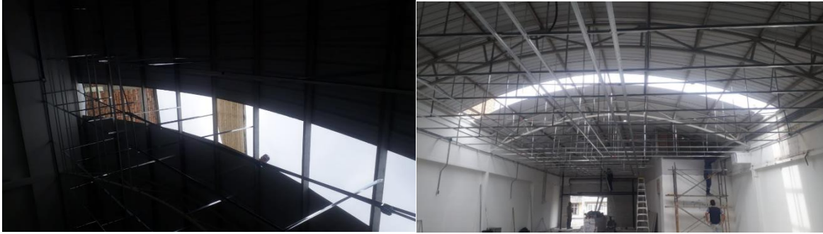
figura 17. Cambio de cubierta Fuente: Elaboración propia
