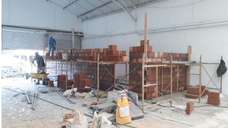
figura 11. Avance de muro Fuente: Elaboración propia
