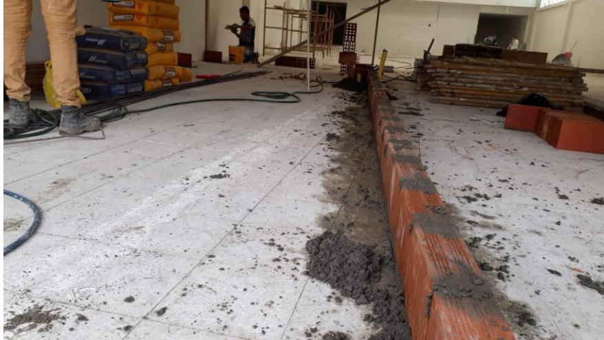
figura 9. Inicio de muro para el local Fuente: Elaboración propia
