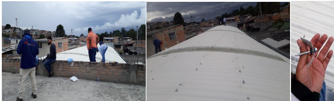
figura 15. Mantenimiento de cubierta Fuente: Elaboración propia
