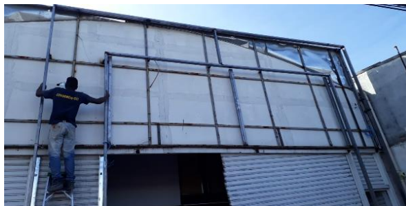
figura 19. Instalación de estructura metálica en fachada Fuente: Elaboración propia
