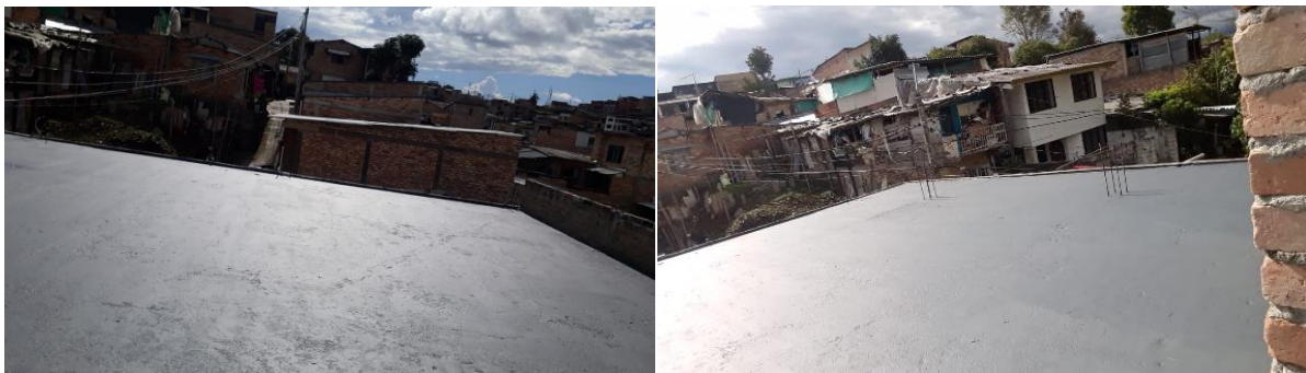
figura 18. Impermeabilización de losa tercer piso Fuente: Elaboración propia
