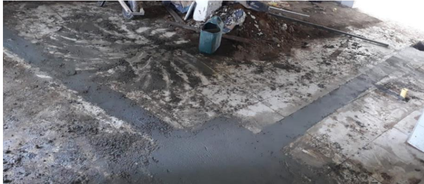
figura 7. Relleno de zanjas Fuente: Elaboración propia
