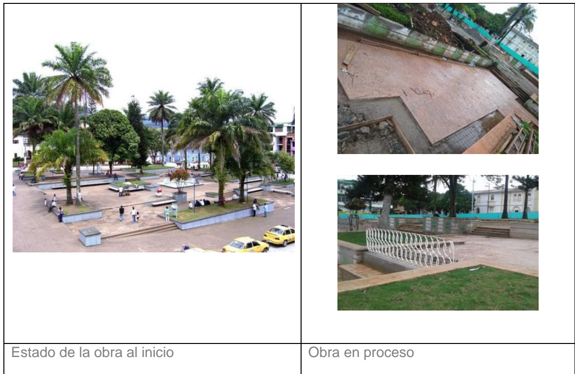
Fotografía 4: Estado de la Obra al Inicio y en Proceso
