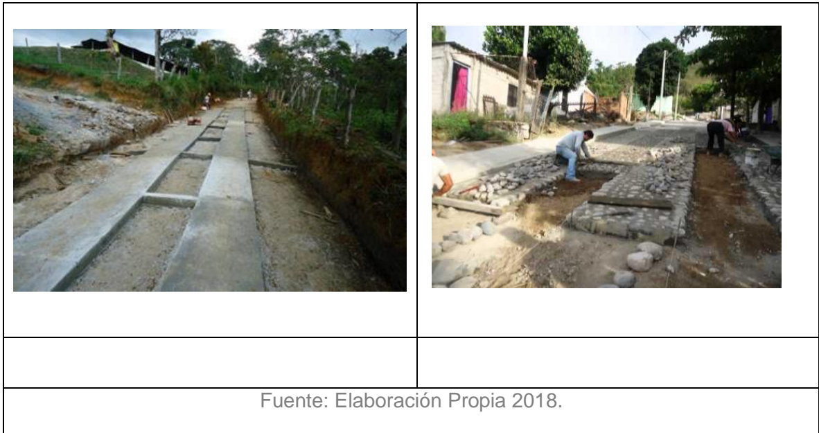
Fotografía 9: Proceso de Construcción Vía Barrio la Ciudadela
