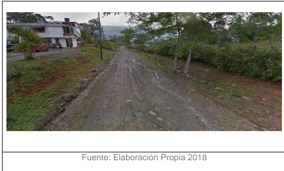
Fotografía 6: Estado de la Vía Antes de la Intervención
