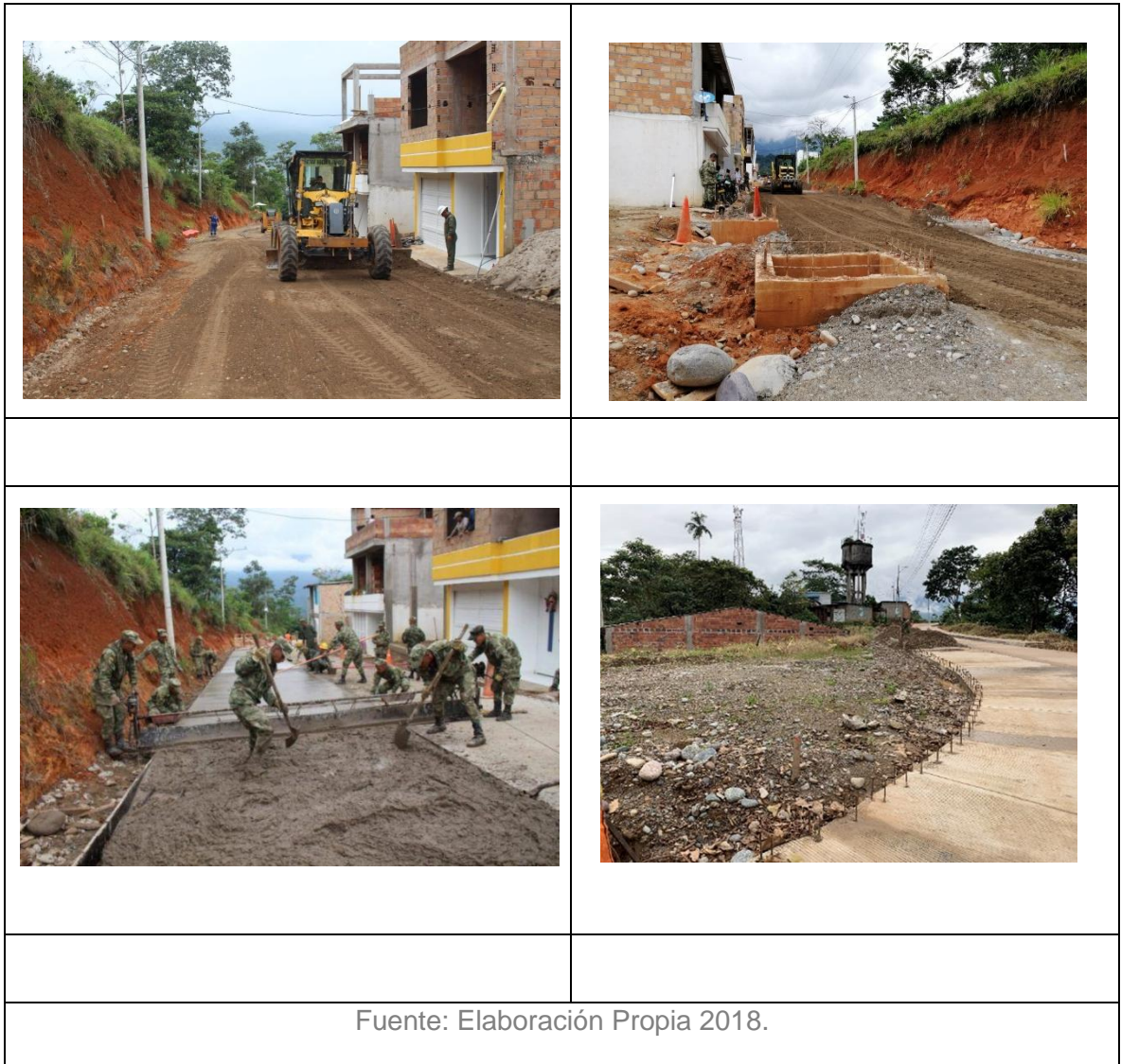
Fotografía 7: Proceso Vía Barrio la Ciudadela
