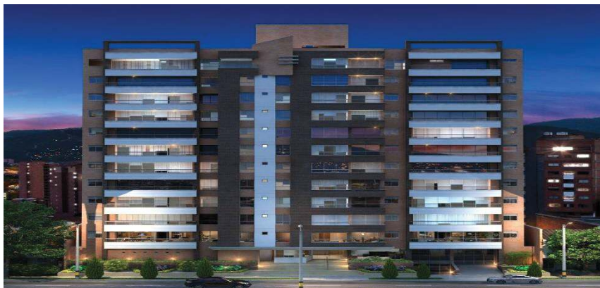
Figura 20 Apartamento No. 2 (Fuente: Grupo San Remo)
