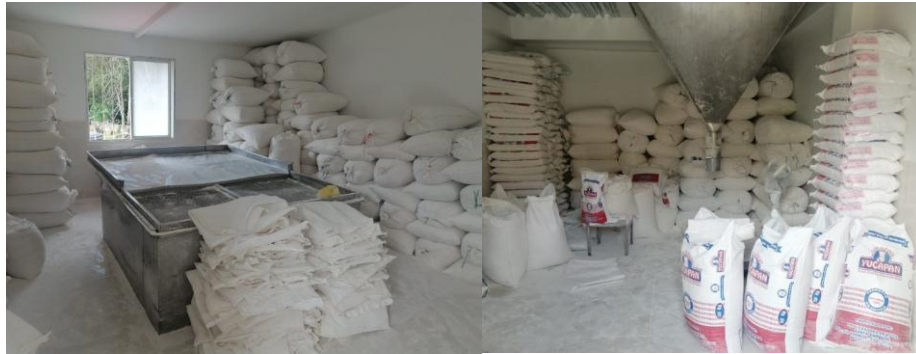
Área de empaque (Segundo piso) y área de Almacenamiento Temporal (primer piso) (DESPUES)
