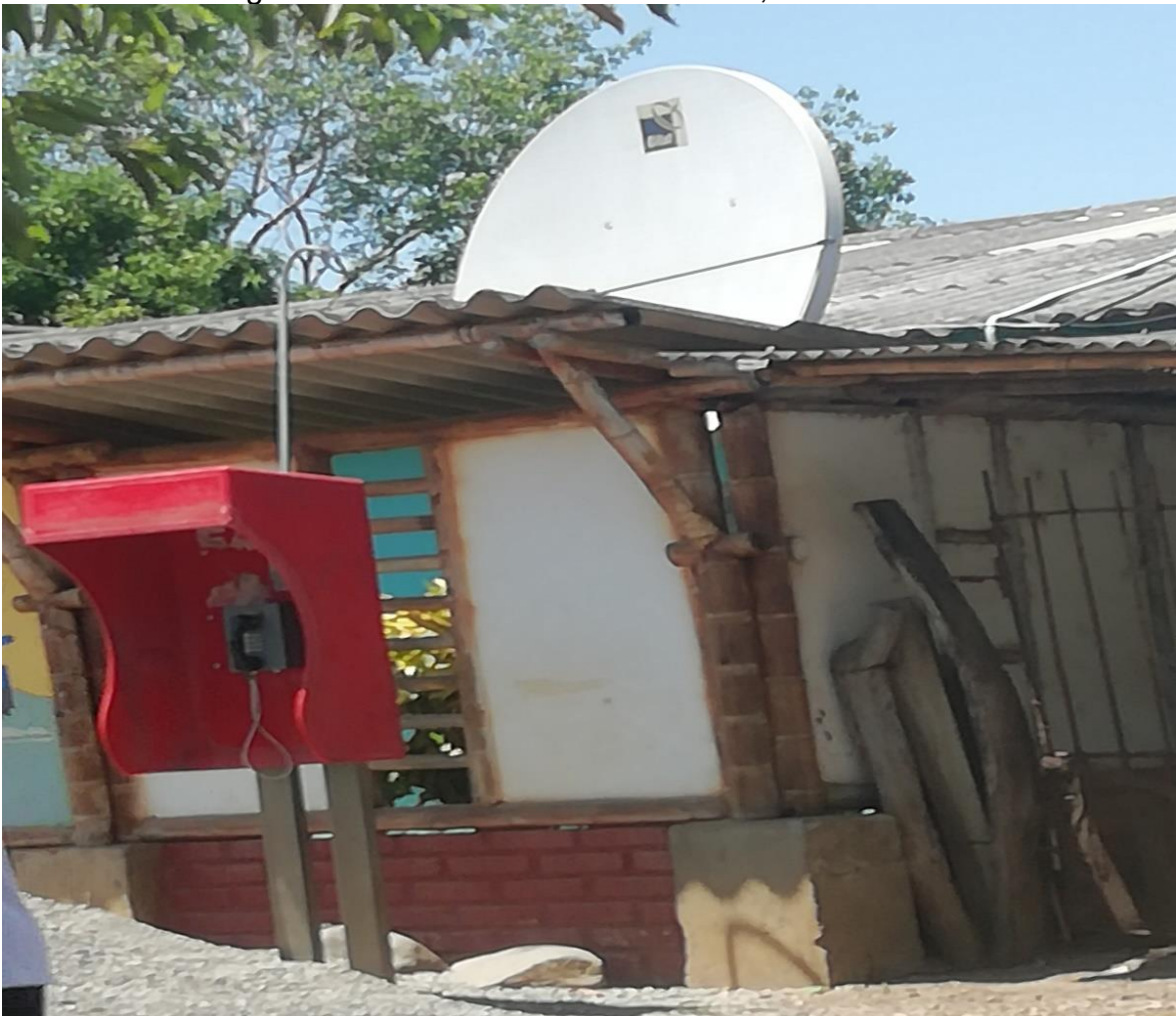
Fotografía. Antena parabólica del "kiosko vive digital"
