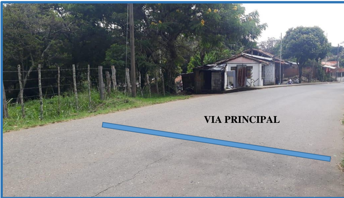
FIG. 11 VÍA PRINCIPAL, SAN PEDRO.
