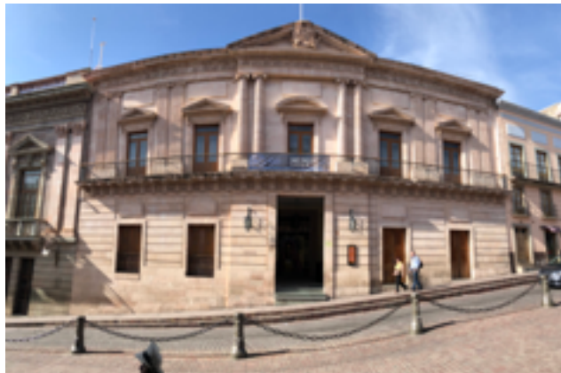
Ilustración 12. Fachada Casa Conde Rull
