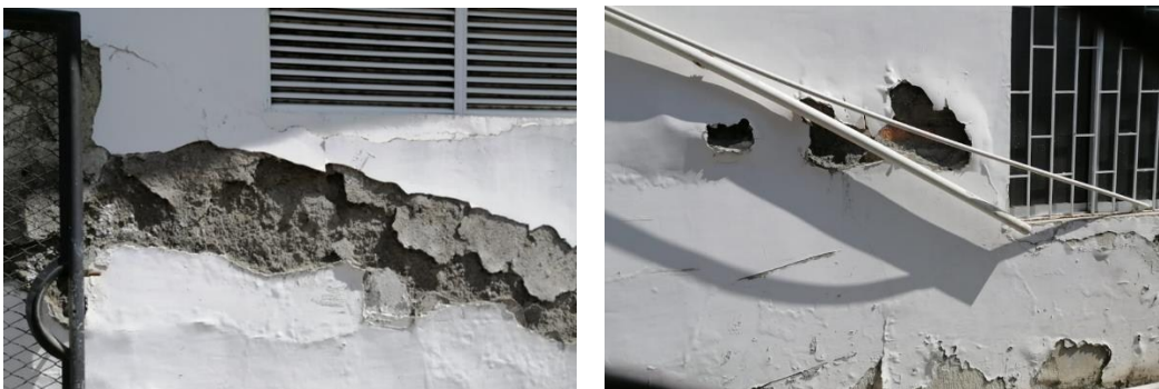
Figura 6 Materiales de construcción de la estructura
