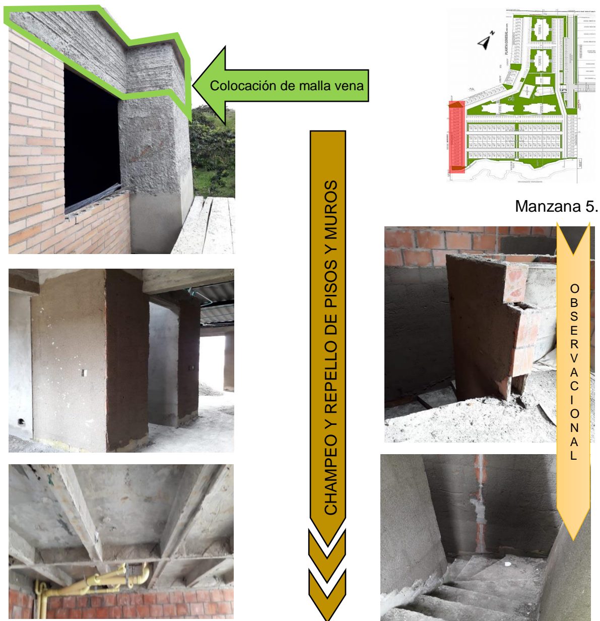
Ilustración 29. Registro fotográfico obra gris
