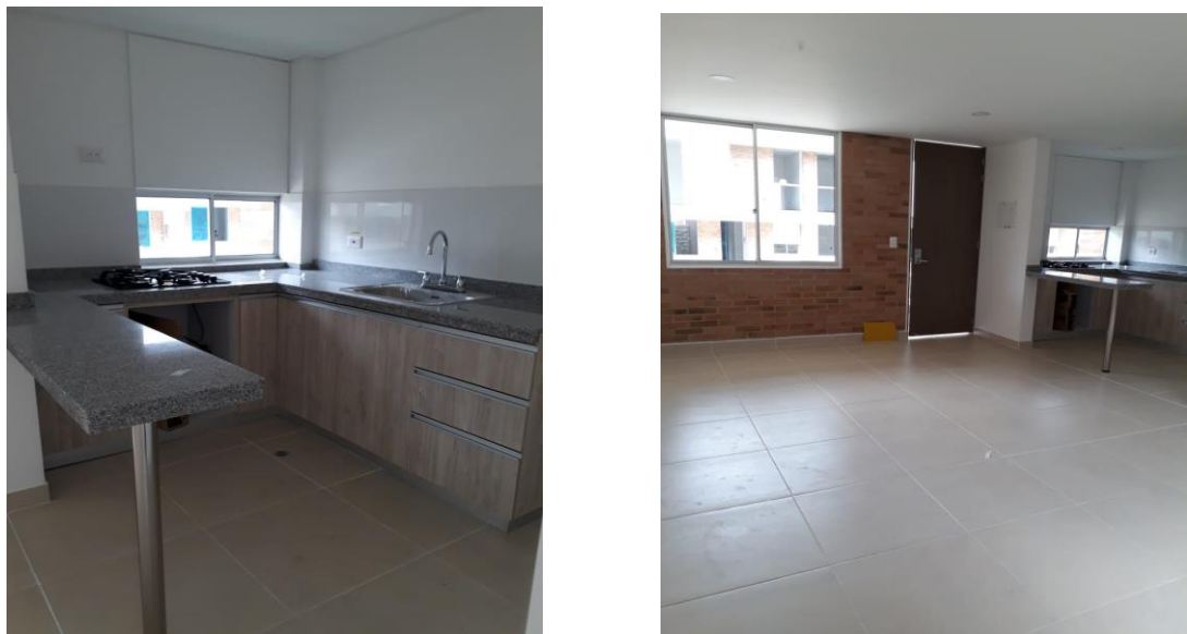
Ilustración 34. Registro fotográfico obra blanca.
