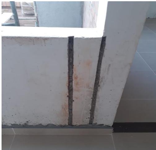
Ilustración 31. Registro fotográfico obra blanca
