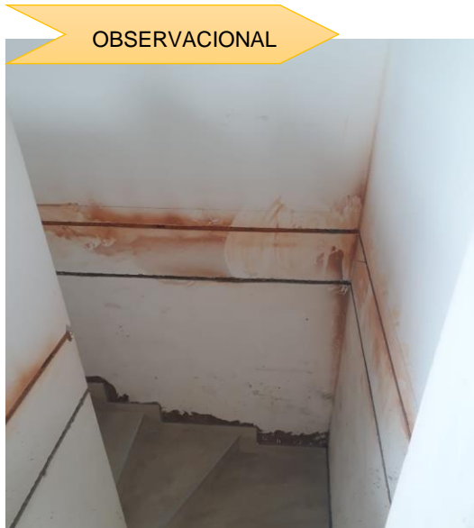
Ilustración 30. Registro fotográfico obra blanca
