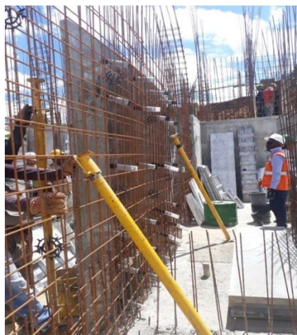
Ilustración 45. Colocación de formaletas
