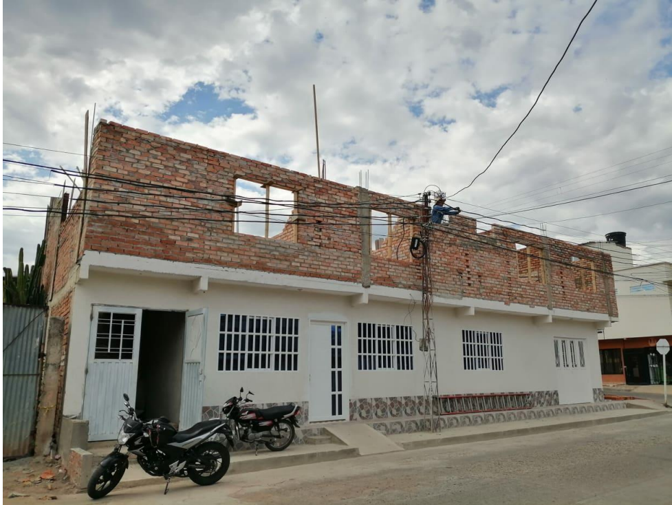
Imagen 15. Visita realizada, detención de la obra.
