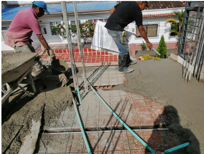
Imagen 17. Visita a obra con licencia de Subdivision aprobada.
