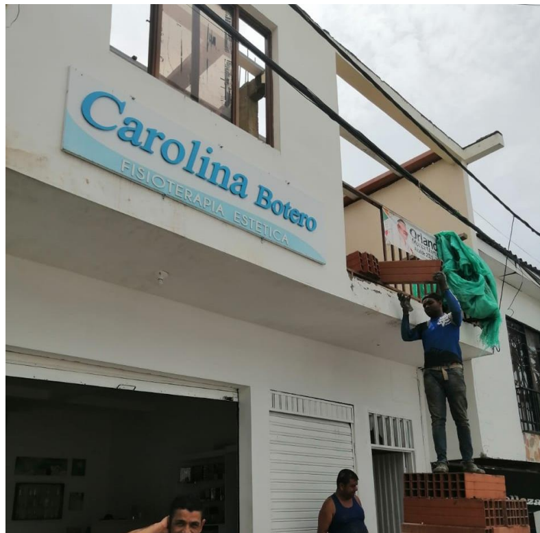
Imagen 5. Visita de interventoría realizada a la obra con licencia aprobada para obra nueva y ampliación.
