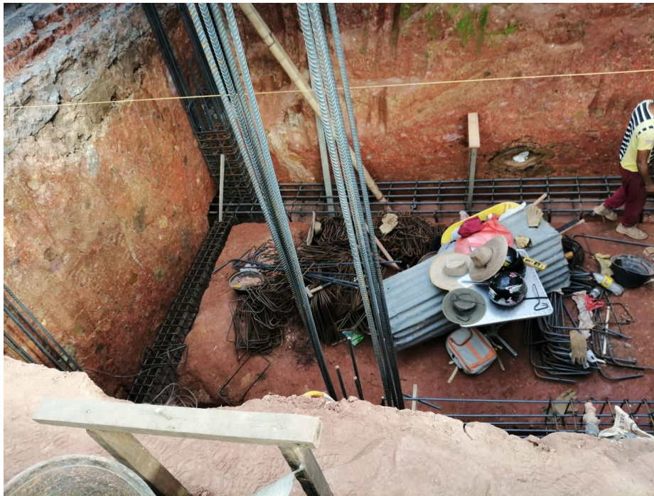
Imagen 7. Visita de interventoría y verificación en licencia de obra nueva
