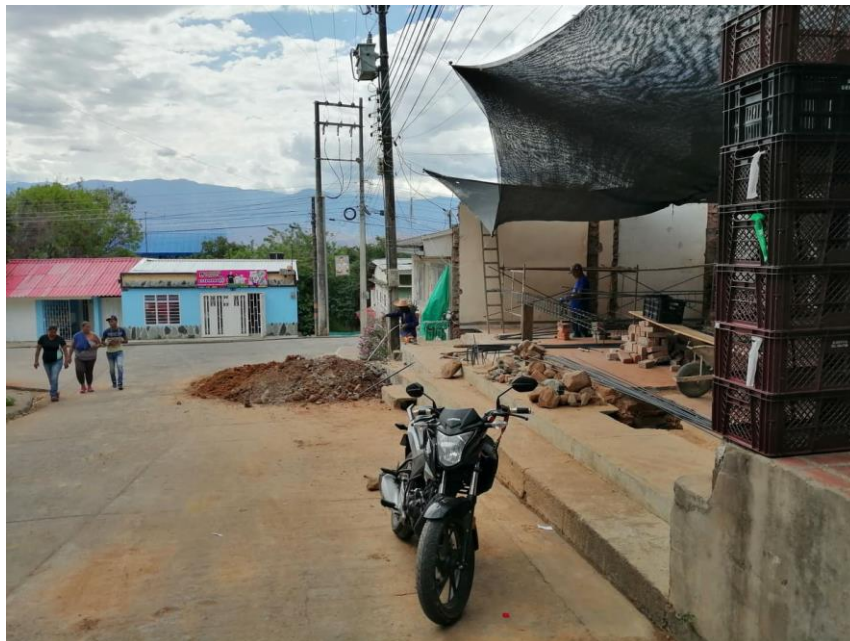
Imagen 14. Visita realizada, detención de la obra.
