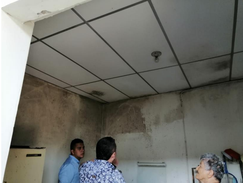
Imagen 16. Visita a obra con licencia de Subdivision aprobada.
