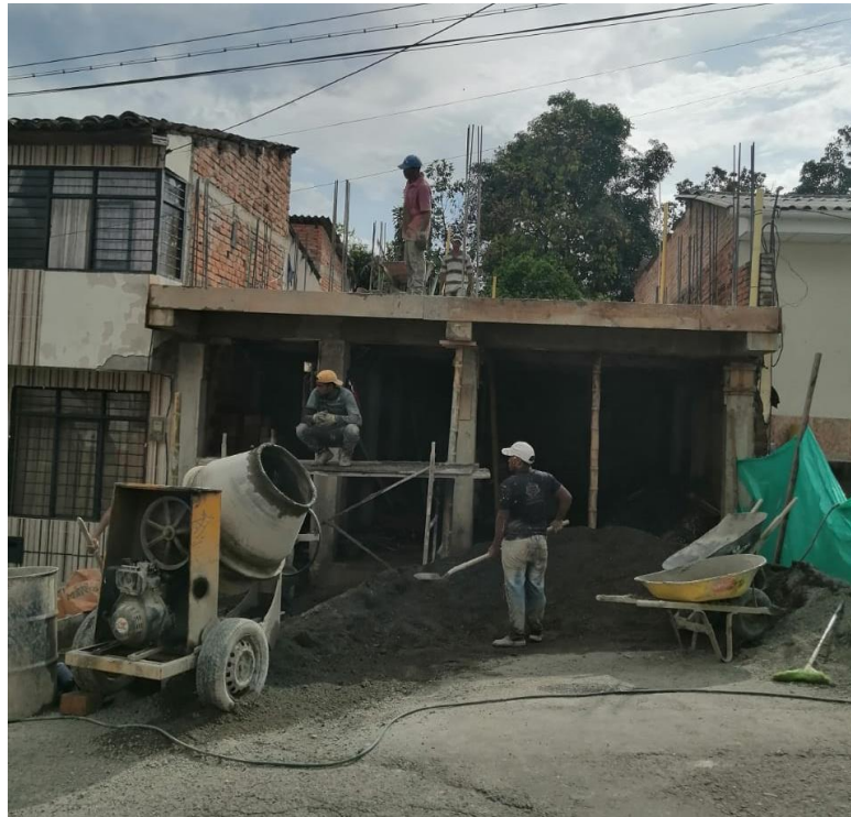
Imagen 13. Visita realizada, detención de la obra.
