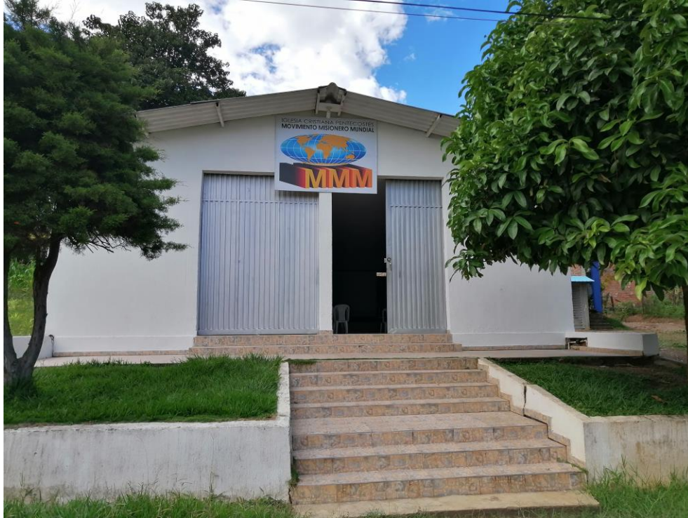
Imagen 18. Visita a obra con licencia de Subdivisión aprobada.
