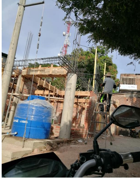
Imagen 6. Visita de interventoría y verificación en licencia de obra nueva.
