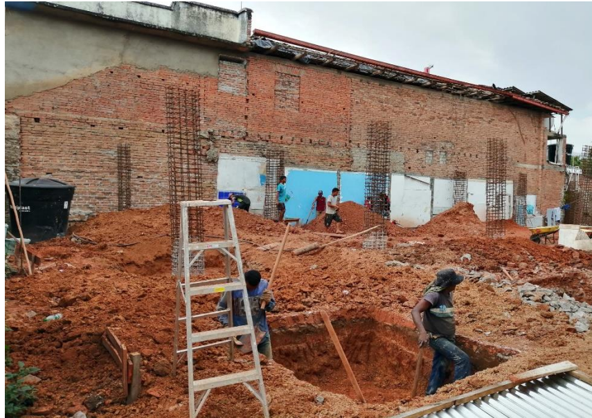
Imagen 4. Visita de interventoría y verificación en licencia de obra nueva
