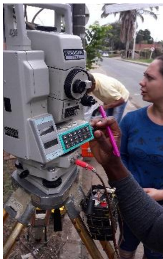
Fig 10: Fuente propia: Fotografía de la estación total utilizada en el levantamiento del puente de los Libertadores de Santander de Quilichao
