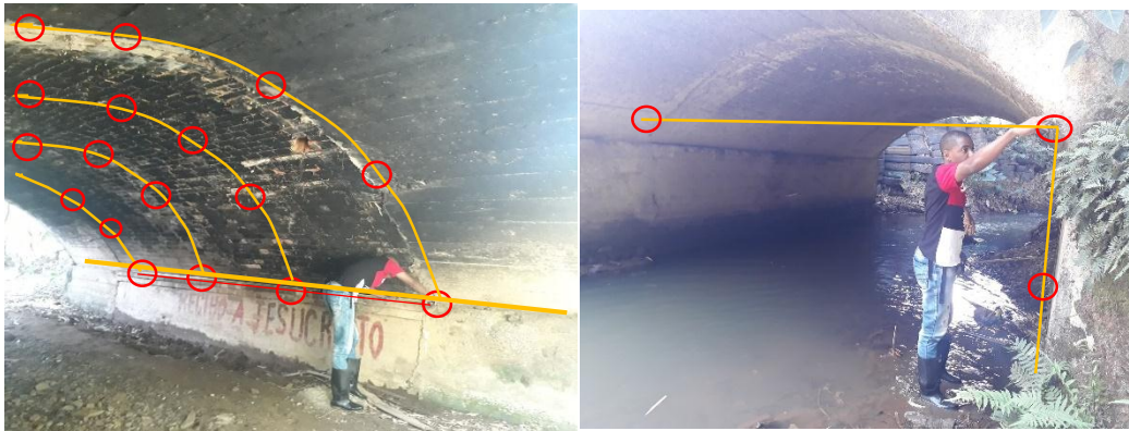
Fig. 19 Fuente propia: toma de puntos de apoyo bóveda 1 occidental
