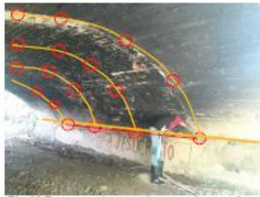
Fig. 19 Fuente propia: toma de puntos de apoyo bóveda 1 occidental
