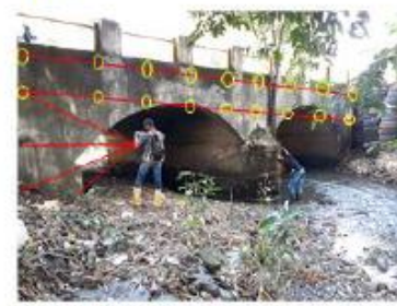
Figura 20 Fuente propia: toma de fachada occidental
