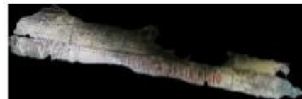
Fuente propia Captación a escala de las partes con menos daño del puente de los libertadores de Santander de Quilichao.
