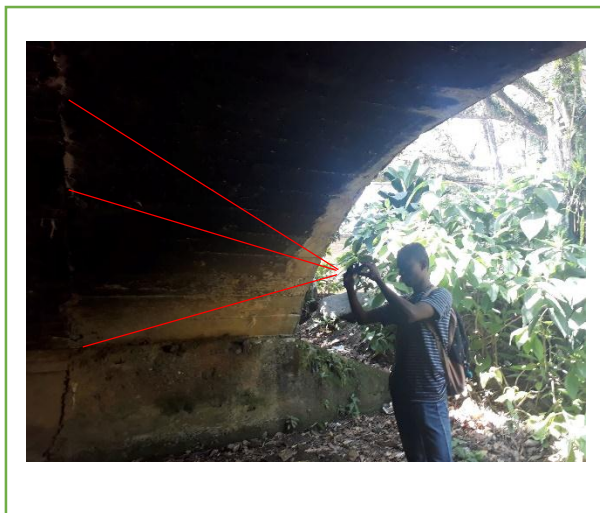
Fig. 22 Fuente propia: toma de fotos interna de la bóveda bóveda
