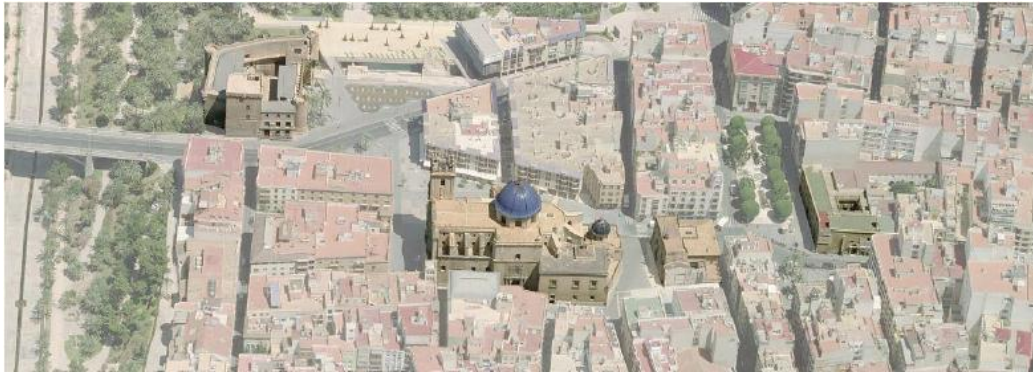
Fig. 6. Vista aérea del centro histórico de la ciudad. Fuente: Grupo de investigación en Restauración Arquitectónica, Universidad de Alicante Alicante, España
