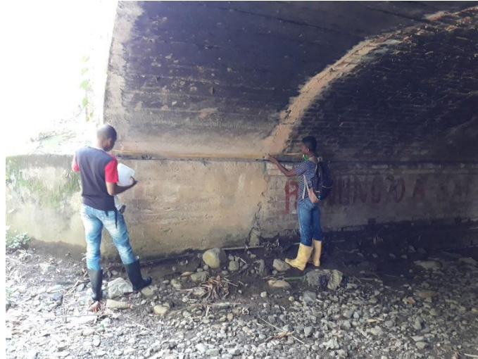
Fig. 24 Fuente propia: retiro de elementos de reconocimiento para el programa PhotoModeler
