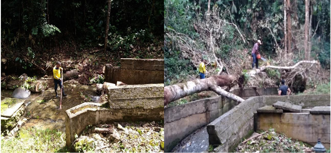
FOTO 20. Limpieza y adecuación de bocatoma
