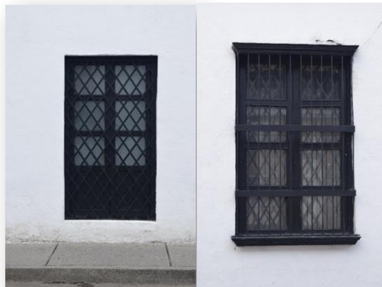
Modelo de una ventana rectangular en madera doble hoja con reja en acero y madera
