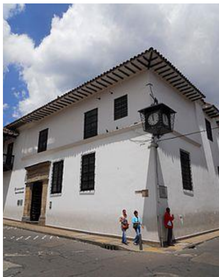
Figura 25: Fachada Casa de la Moneda de Bogotá Fuente: http://www.banrepcultural.org/bogota/casa-de-moneda
