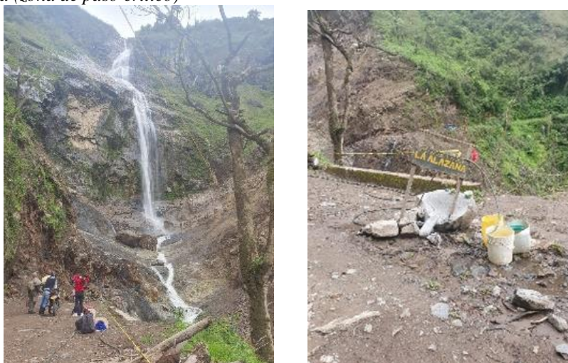
Quebrada la Alazana (zona de paso crítico)
