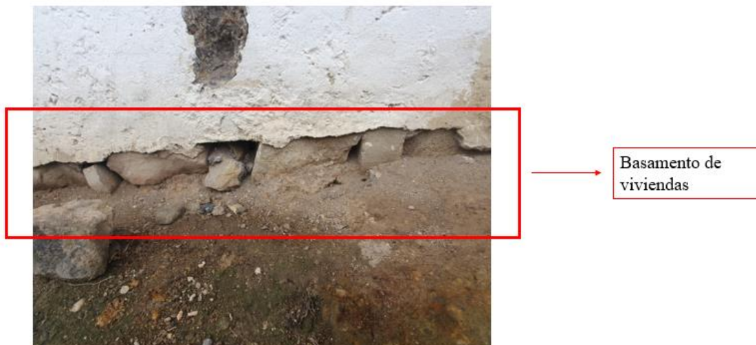
Figura 27 Basamento de viviendas
