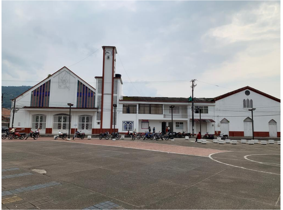
Ilustración 9, fotografía del estado actual de la iglesia Nuestra Señora de Fátima (2022) 9
