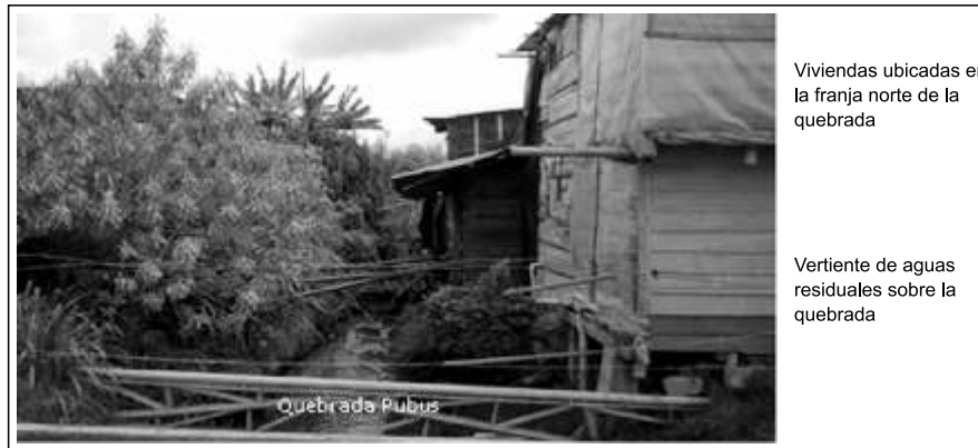
Figura 5. Vivienda con vertientes a la quebrada
