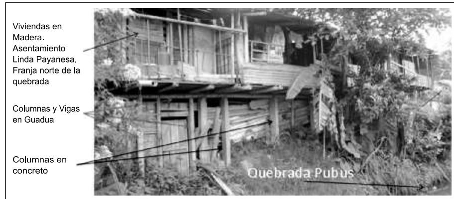
Figura 4. Vivienda sobre la quebrada
