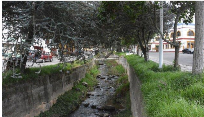
Fotografía 10. Estado actual de área a intervenir
