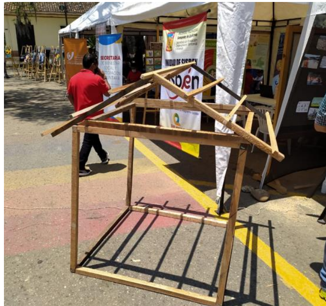
Imagen N°62- Maqueta esquemática para explicarles a los afectados, las partes faltantes de su cubierta.
