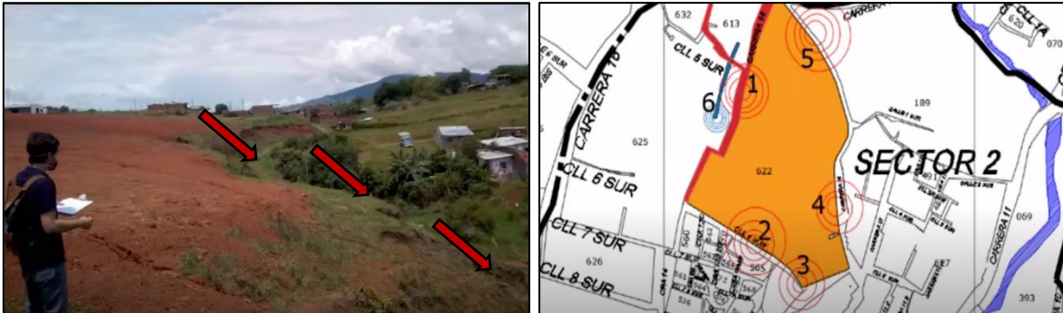
Imagen N°11. Visita técnica de inspección del lote 622, Genera daños a las viviendas vecinas, debido a la comunidad en su afán de ocupar el territorio, no determino que podía afectar a sus vecinos, por efectos de Remoción en masa.
