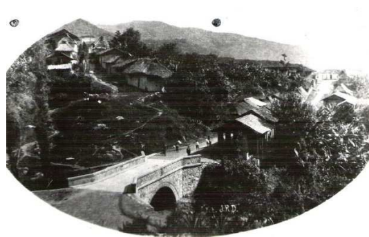
Imagen 7 Nuevo puente, barrio "calle nueva" y "altozano"
