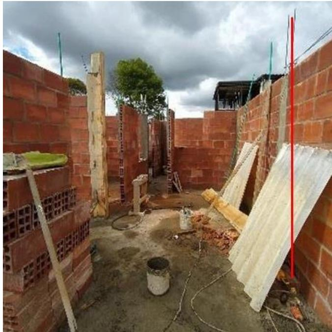
Hay una conjugación de elementos estructurales diferentes. Se observan columnetas (sistema estructural confinado) y columnas con secciones de 20x20 cm de naturaleza aporticado. Se conjugan los sistemas confinados con ladrillos farol o huecos, lo que no brinda ningún tipo de seguridad en el comportamiento estructural de la edificación.
