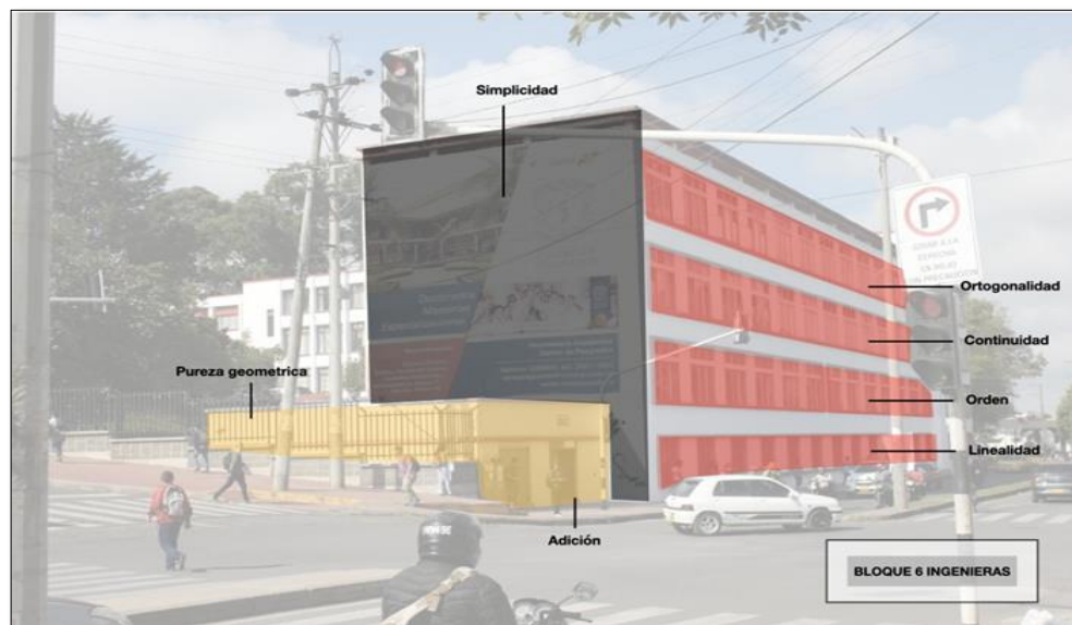
Imagen 51 Análisis de fachadas – 2 Edificio de Ingenierías
