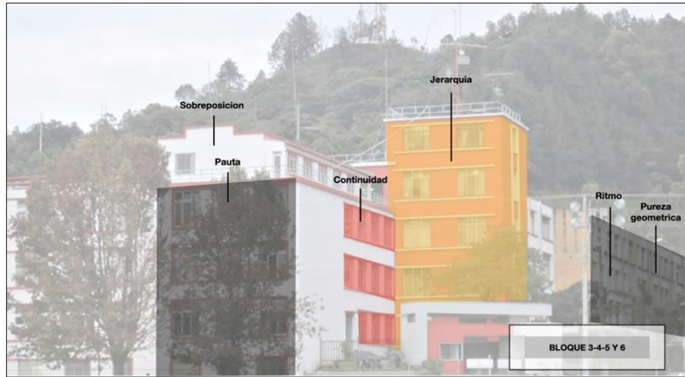
Imagen 50 Análisis de fachadas Edificio de Ingenierías
