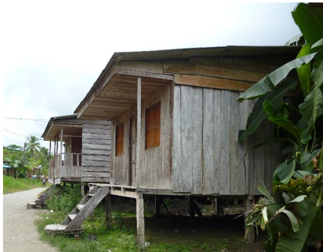
Imagen 24. Vivienda Palafítica, Puerto Merizalde.
